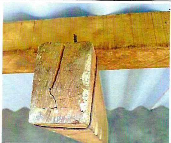
**Imagen n.º 28:** En la ejecución, se ha utilizado madera corriente para la estructura de soporte del techo de los UBS. Distinto a lo previsto en el expediente técnico. (Color amarillento a blanquecino).
