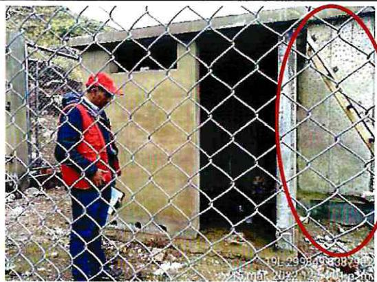
**Imagen n.º 10:** Zona frontal del reservorio, donde se constata que falta su tarrajeo exterior.
