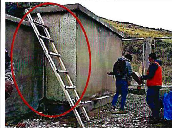
**Imagen n.º 9:** Zona frontal del reservorio, donde se constata que falta su tarrajeo exterior.
