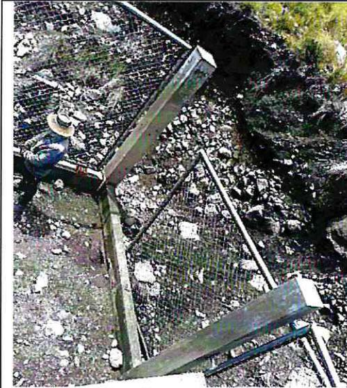
**Imagen n.º 7:** Zona de reservorio, donde se constata que los tableros con malla en muros se dejaron en estado de colocación sin culminar.
