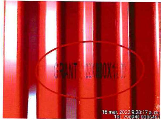
**Imagen n.º 26:** En la ejecución, se colocó la cobertura de calamina de espesor de E=0,22 mm. Distinto a lo previsto en el expediente técnico.
