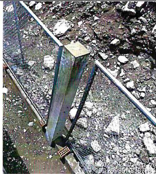
**Imagen n.º 8:** Zona de reservorio, donde se constata que los tableros con malla en muros se dejaron en estado de colocación sin culminar.
