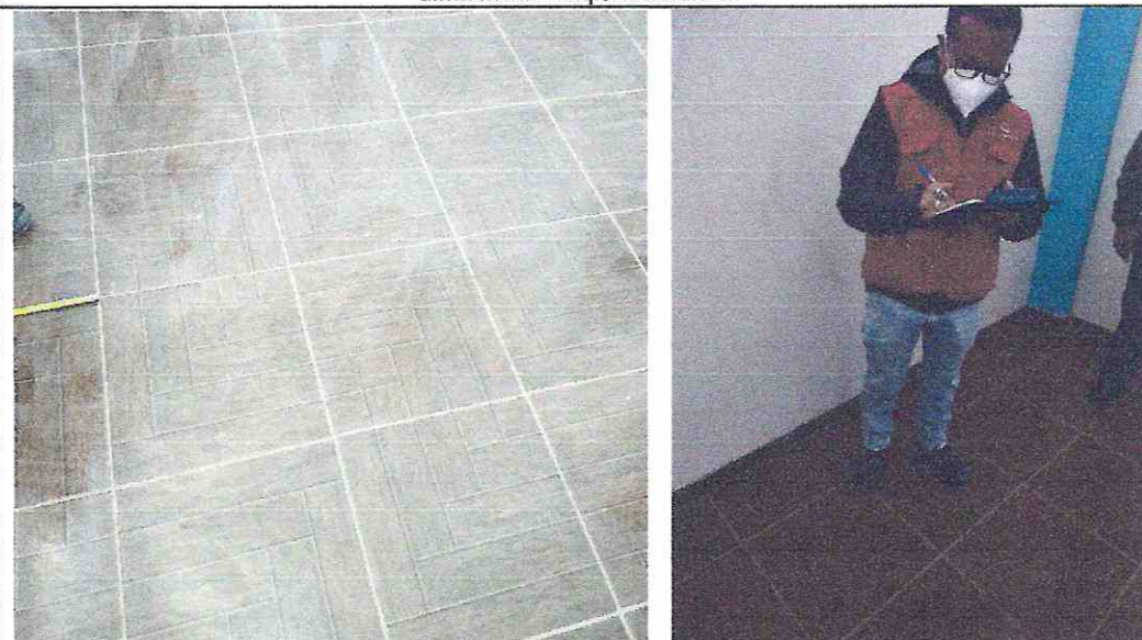
Fotografías n.ºs 11 y 12 Verificación del piso de parquet en ambientes del primer nivel del componente "Construcción de ambientes complementarios"
