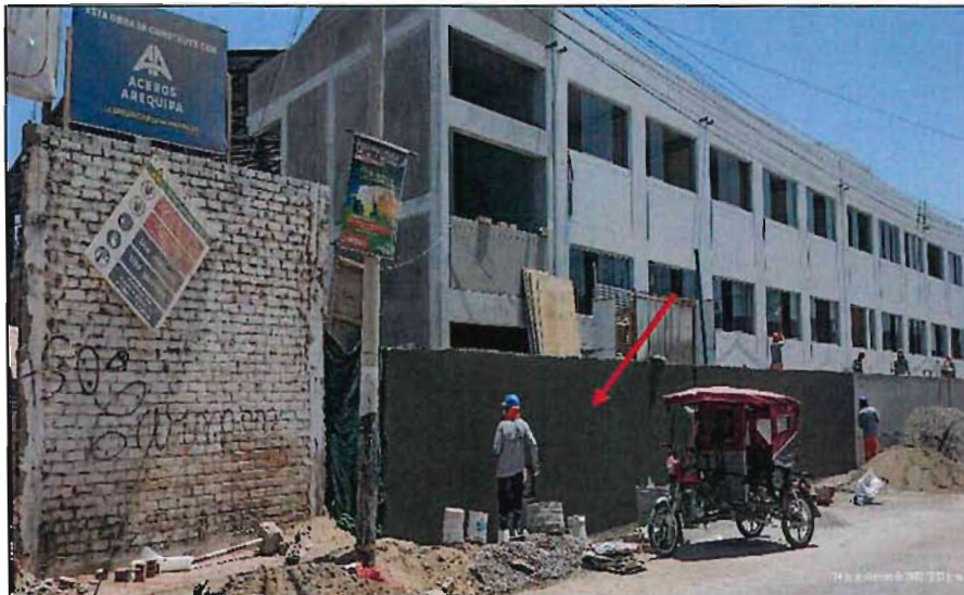
Imagen n.º 42 Muro en proceso de tarrajeo
