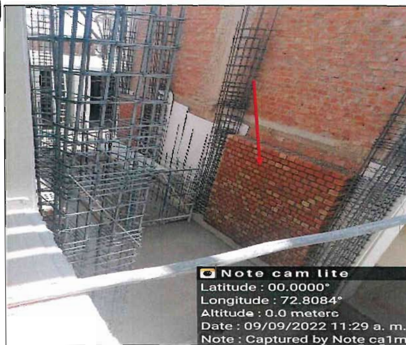
Imagen N° 5 Asentado de Ladrillo
