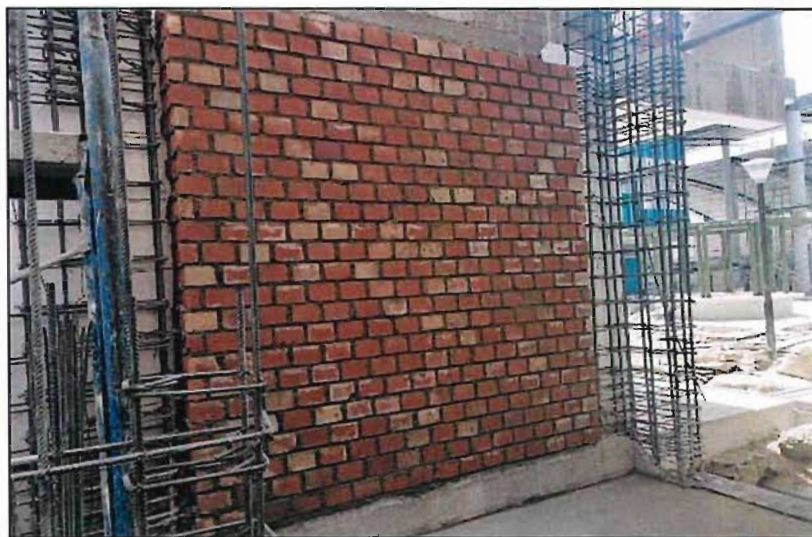
Imagen N° 6 Asentado De Ladrillo
