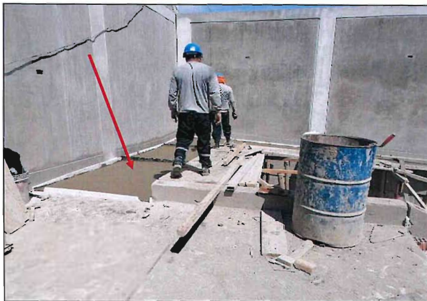
Imagen n.º38 Ejecución de Rampa
