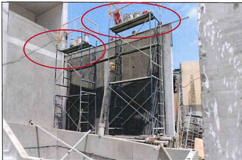
Imagen N° 1 Tarrajeado De Muro
