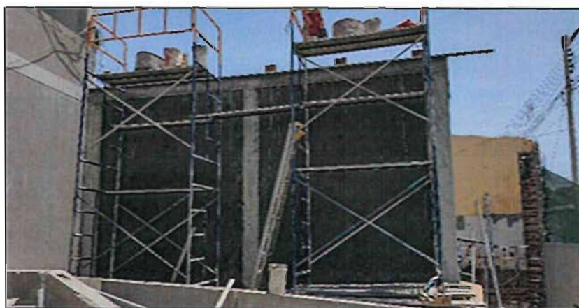
Imagen N° 2 Tarrajeado de muro
