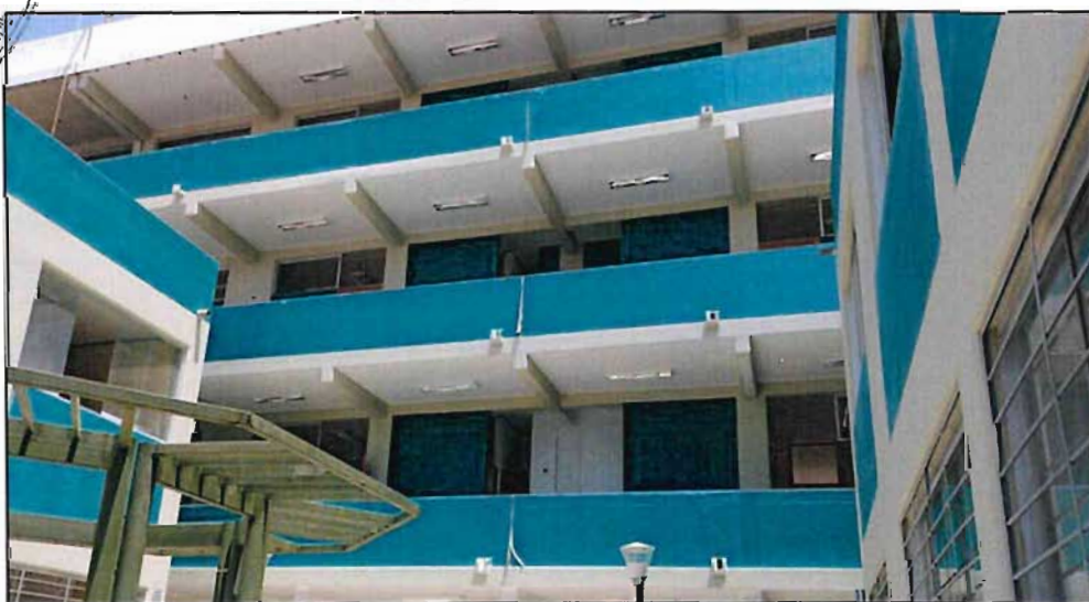
Imagen n.º49 Niveles 2 al 4 Pabellón sin anclado de fierro de protección
