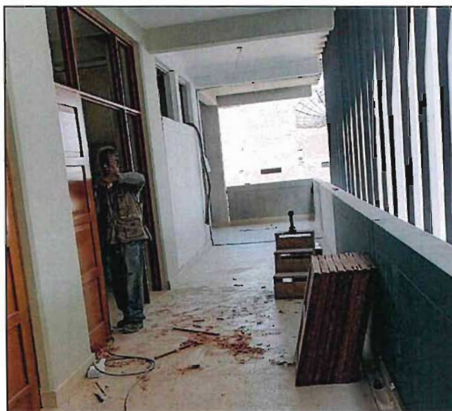
Imagen n.º81 Ejecución de instalación de bisagras
