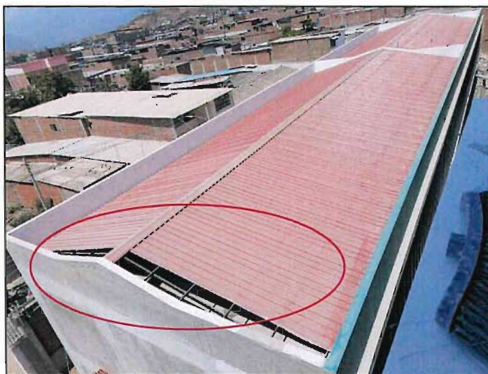
Imagen n.º79 Pabellón con cobertura inconclusa
