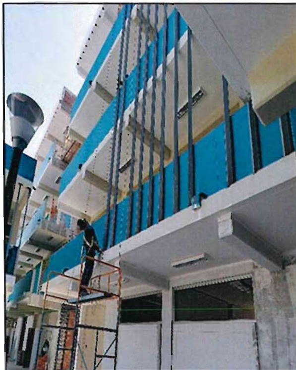
Imagen n.º90 Niveles 2 al 4 anclado de fierro de protección
