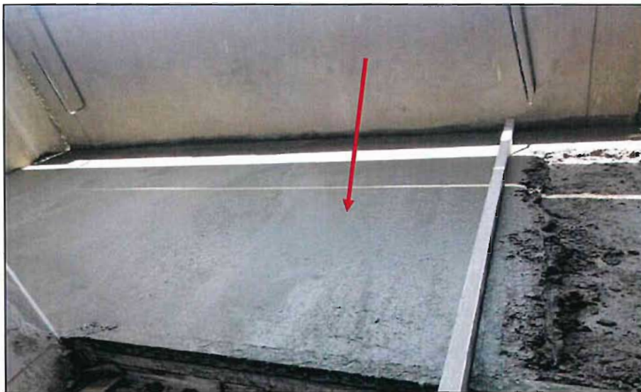
Imagen n.º 22 Mezcla de mortero de falso piso de escalera
