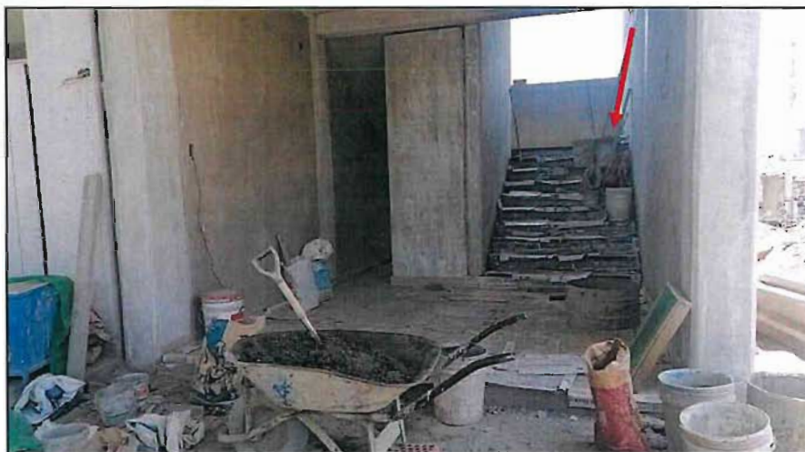
Imagen n.º 22 Mezcla de mortero de falso piso de escalera
