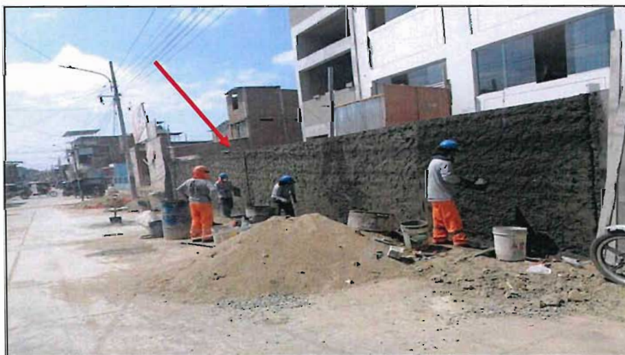
Imagen n.º 41 Muro en proceso de tarrajeo
