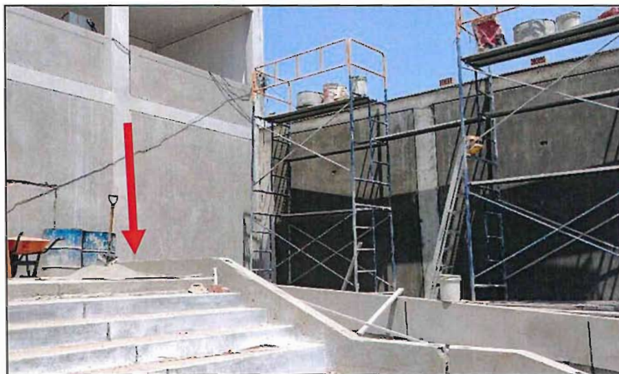
Imagen N° 3 Tarrajeado de muro
