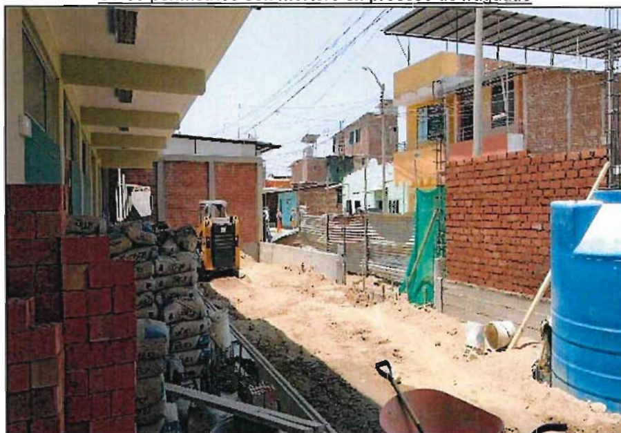
Cerco perimétrico con mortero en proceso de fraguado
