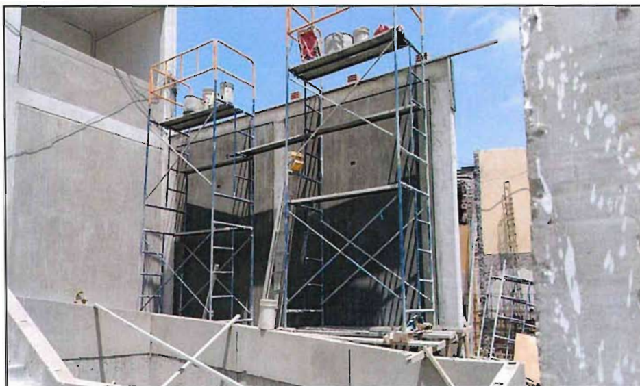
Imagen n.º 40 Zona de Proyección de Rampa
