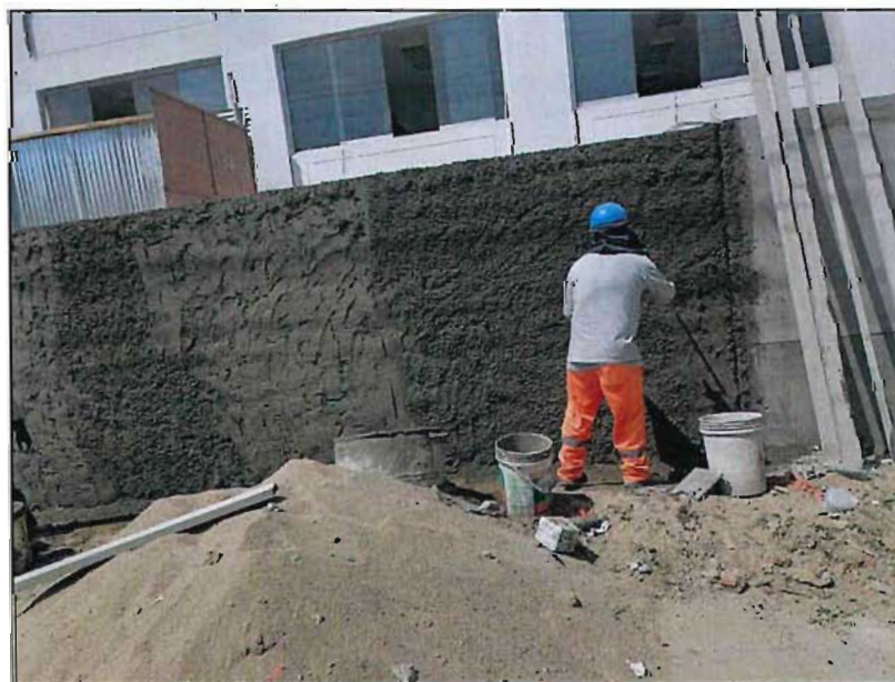
Imagen n.º76 Tarrajeo de cerco perimétrico por calle Lima
