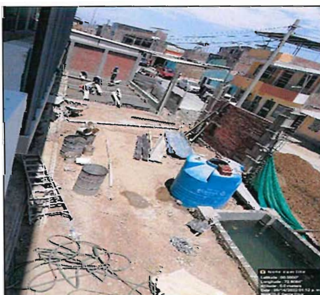
Imagen n.º 55 Ejecución de la losas de concreto en zona de estacionamiento frente a la calle Ica.
