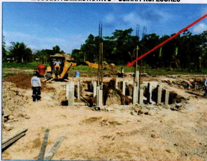
IMAGEN N° 5 TRABAJOS DE RELLENO CON MATERIAL PROPIO MODULO: ADMINISTRATIVO + SS.HH. PROFESORES
