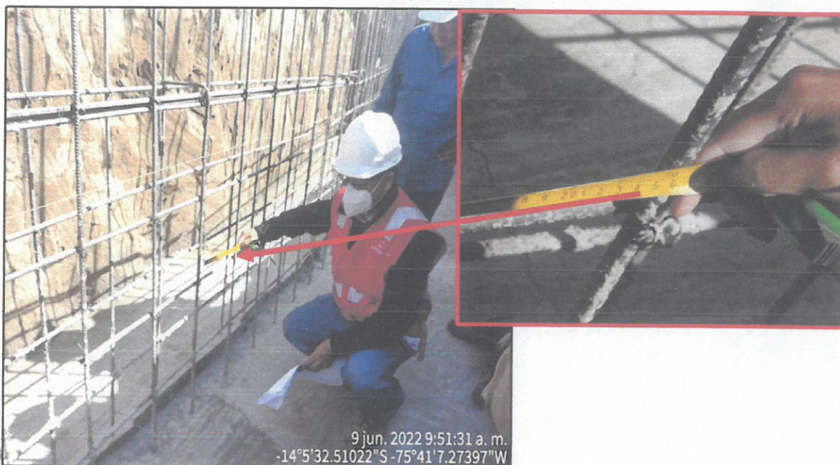
Imagen N° 3 Distribución de aceros verticales de diámetro de \frac{1}{2} " a cada 0,25 m
