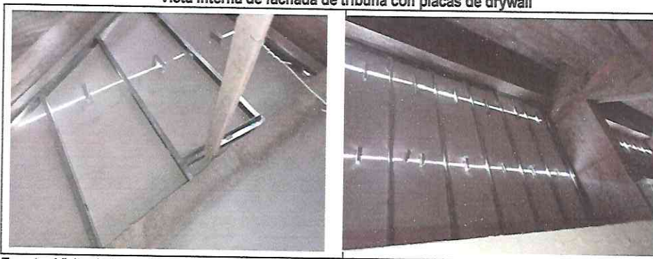
Imagen n.º 5 Vista interna de fachada de tribuna con placas de drywall
