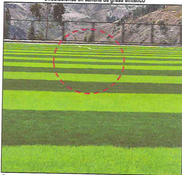
Imagen n.º 17 Ondulaciones en cancha de grass sintético
