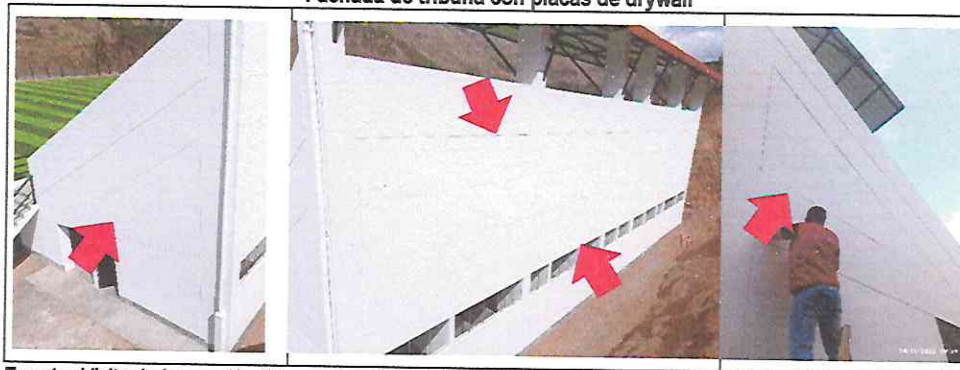
Imagen n.º 4 Fachada de tribuna con placas de drywall
