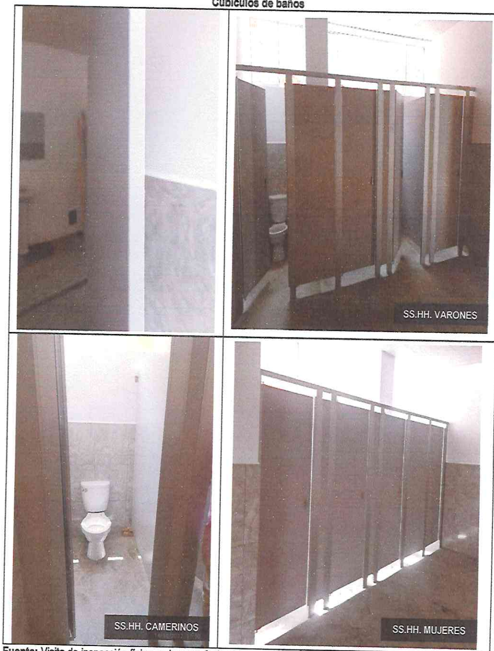
Imagen n.º 10 Cubículos de baños
