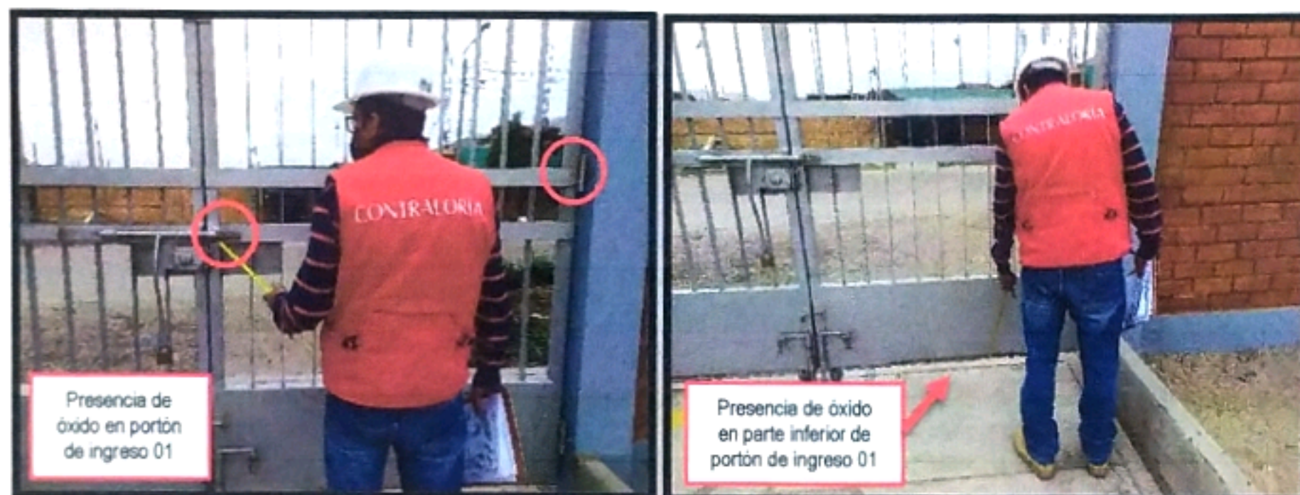
IMAGEN N° 19 PORTON METÁLICO DE INGRESO 01
