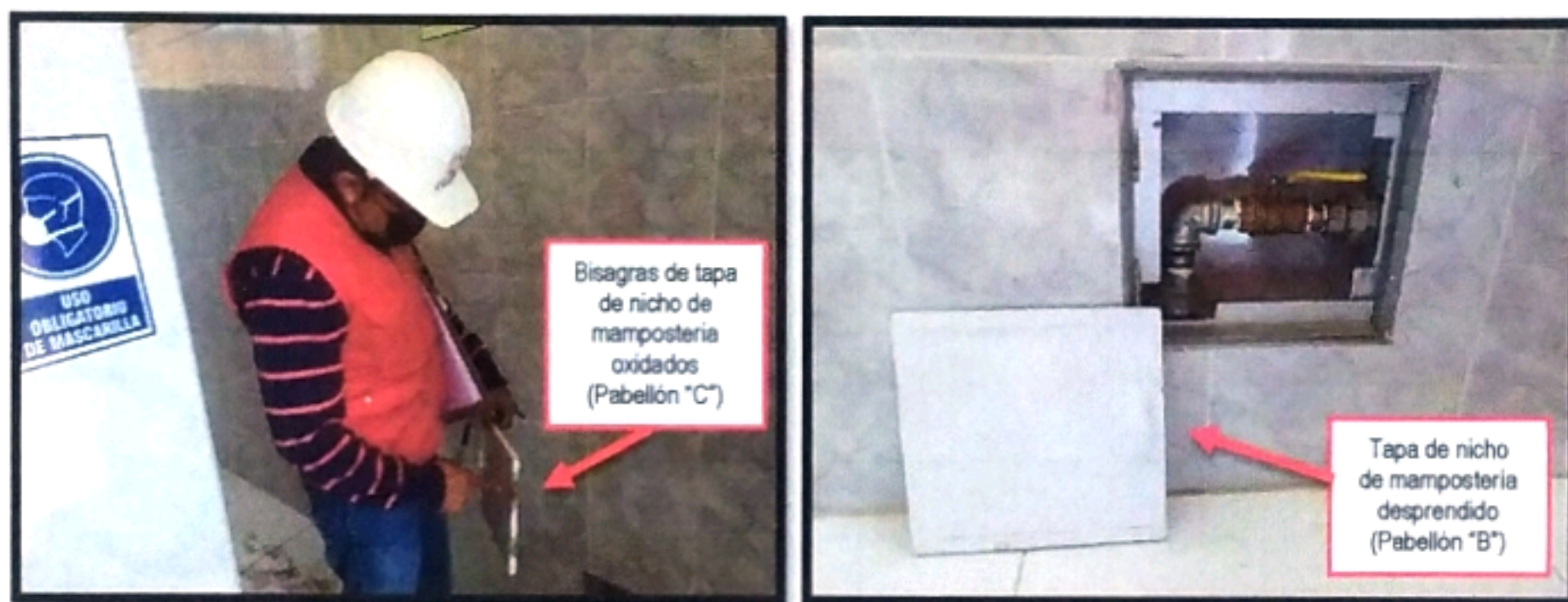
IMAGEN N° 15 NICHO DE MAMPOSTERÍA
