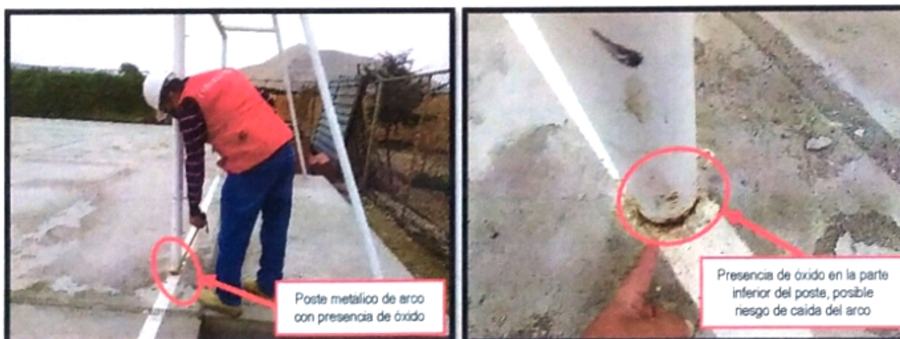
IMAGEN N° 24 POSTE METÁLICO DE ARCO
