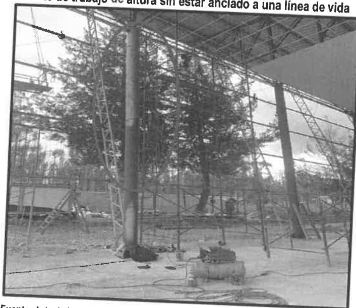
Imagen n.º 9 Frente de trabajo de altura sin estar anclado a una línea de vida
