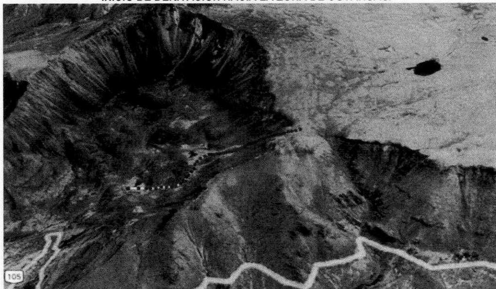
IMAGEN N° 4 INICIO DE DERIVACIÓN HACIA LA ZONA DE COTAHUASI
