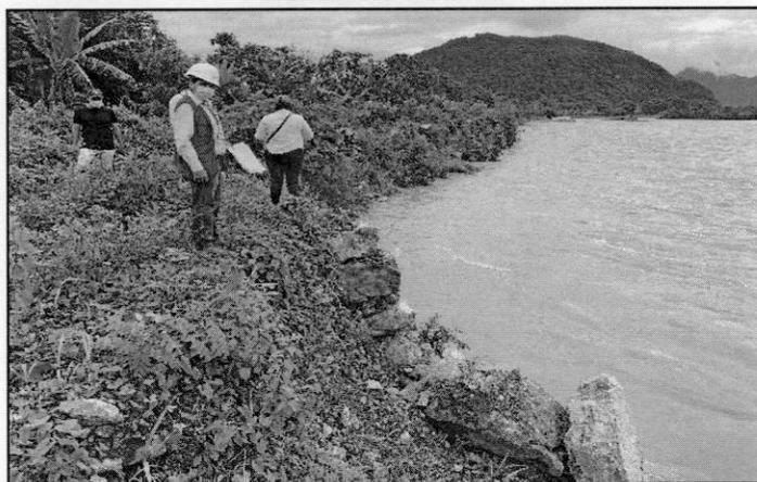
Espigón n.º 6 ubicado en la progresiva 2+530 Km. se encuentra colapsado, evidenciándose rocas de diámetro inferior a 0.70m y material de relleno.
