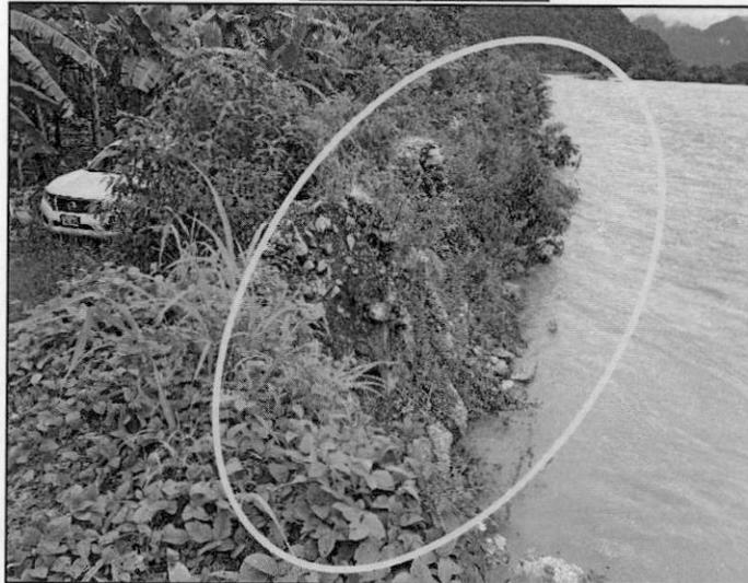
Muro de enrocado colapsado, compuesto por material de relleno y rocas con diámetros inferiores a 0.70 m.
