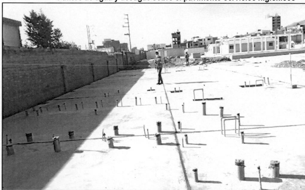
Imagen n.º 24 Puntos de agua y desagüe sobre el pavimento servicios higiénicos
