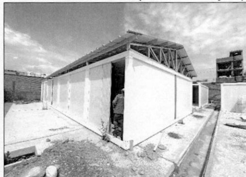
Imagen n.° 14 Módulo de aula n.° 02 (Aulas n.°s 02 y 07)
