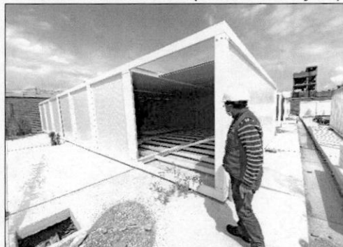
Imagen n.° 16 Módulo de aula n.° 04 (Aulas n.°s 04 y 09)
