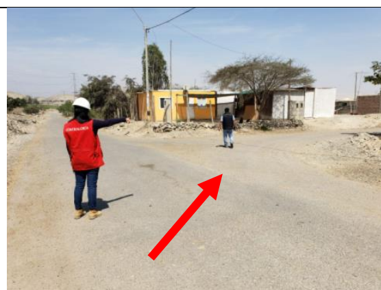
Imagen n.º21.- Ingreso del segundo tramo, a la altura de la progresiva 0+530 del primer tramo.
