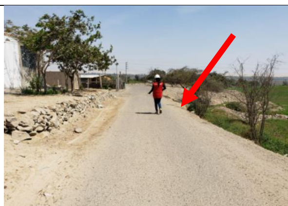
Imagen n.º22.- Se verificó que en la progresiva 0+050 aproximadamente, presenta una reducción de la sección, quedando en 4.05 m de sección de vía.
