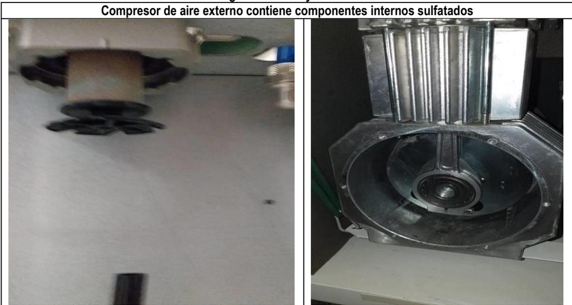
Se evidencia que compresor de aire externo contiene componentes con restos de polvo y sulfatado, no se evidencia la reparación del equipo.
