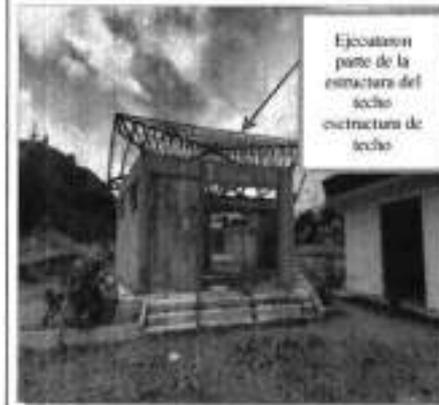
**Fotografía n.º 8:** Solamente se colocaron marcos de puertas y ventanas; asimismo solamente parte de las estructuras metálicas del techo.
