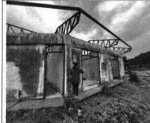
Fotografía n.º 12: Estado módulo de Cuarto de Máquinas; se encuentra a la intemperie, lo cual viene ocasionando el deterioro de las estructuras metálicas del techo, mayólicas y tarrajes.
