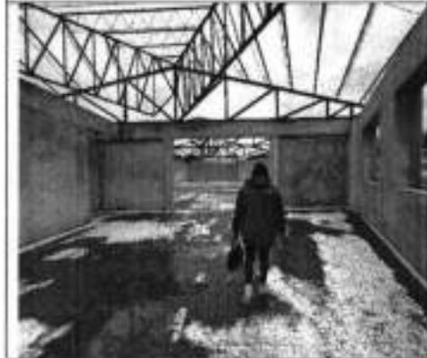
**Fotografía n.º 18:** Estado de los SSHH del Auditorio; el cual, se encuentra a la intemperie lo cual viene ocasionando el deterioro de las estructuras metálicas del techo, tarrajos y mayólicas; asimismo viene siendo usada como baños por lo transeúntes.
