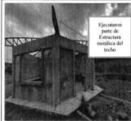
**Fotografía n.º 10:** Solamente colocaron marcos de puertas y ventanas; asimismo no colocaron piso de cerámico y solamente parte de las mesas de concreto.
