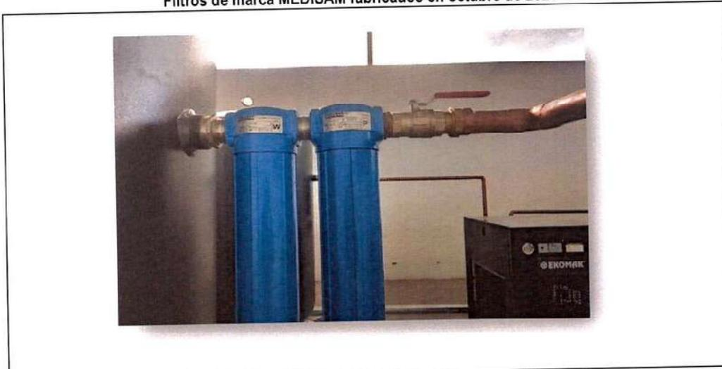
Vista de los filtros marca Medisam: el primero del **Tipo:** WSA 40, **Grado:** W, **Presión máxima:** 16 bar, **Temperatura máxima:** 65 °C, **Fecha de fabricación:** 23 de octubre de 2021; y el segundo del **Tipo:** MHA 530 P, **Elemento:** E 530 P, **Grado:** P, **Presión máxima:** 16 bar, **Temperatura máxima:** 65 °C, **Fecha de fabricación:** 8 de octubre de 2021.
