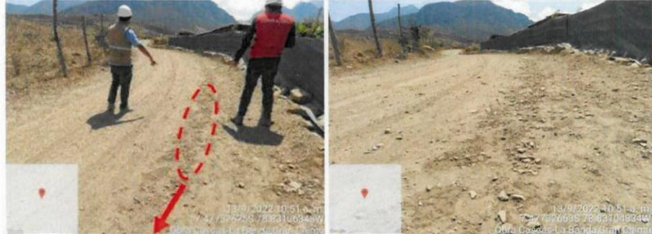
**Imagen n.º 10 - Deformación con gravedad tipo 1 (Hundimiento de 4.00cm).**
