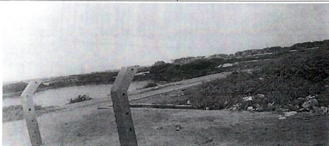
Imagen n.º 13. Se aprecia abundante vegetación en la laguna de oxidación.
