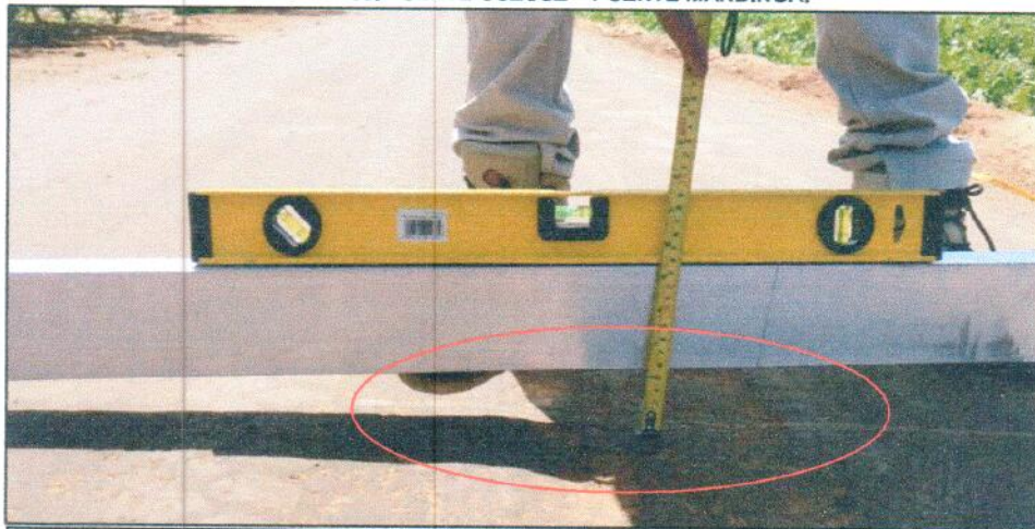
FOTOGRAFIA N° 20 EMP AN 109, PUENTE CUZCUZ - PUENTE MANDINGA.
