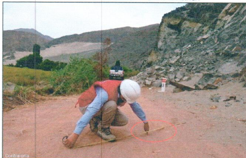
Se observan huella/hundimientos del afirmado en el camino vecinal.
