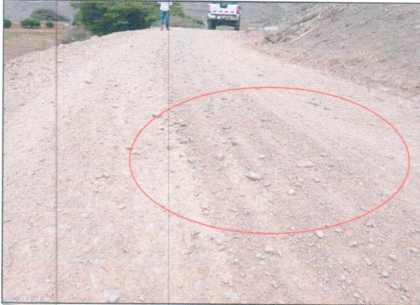
FOTOGRAFIA N° 17 EMP. PE-1N (HUARMEY) - LECHERAL - CUZCUZ - EMP. AN-109.
