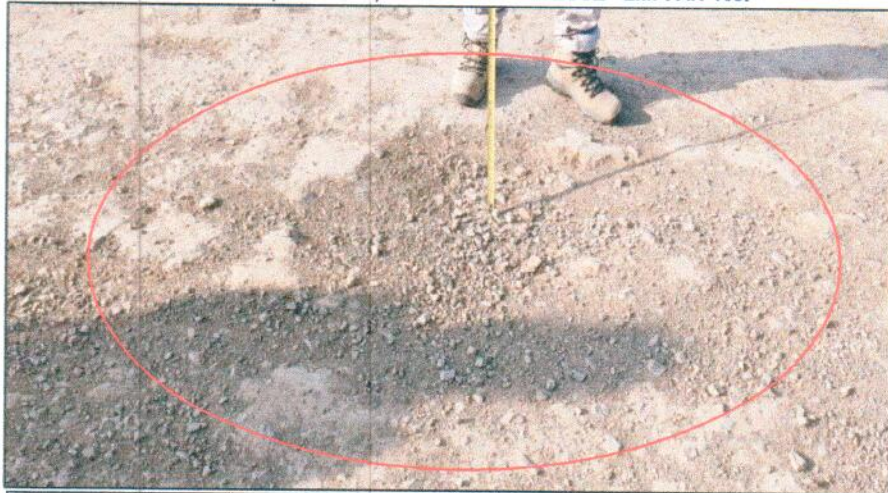
FOTOGRAFIA N° 16 EMP. PE-1N (HUARMEY) - LECHERAL - CUZCUZ - EMP. AN-109.
