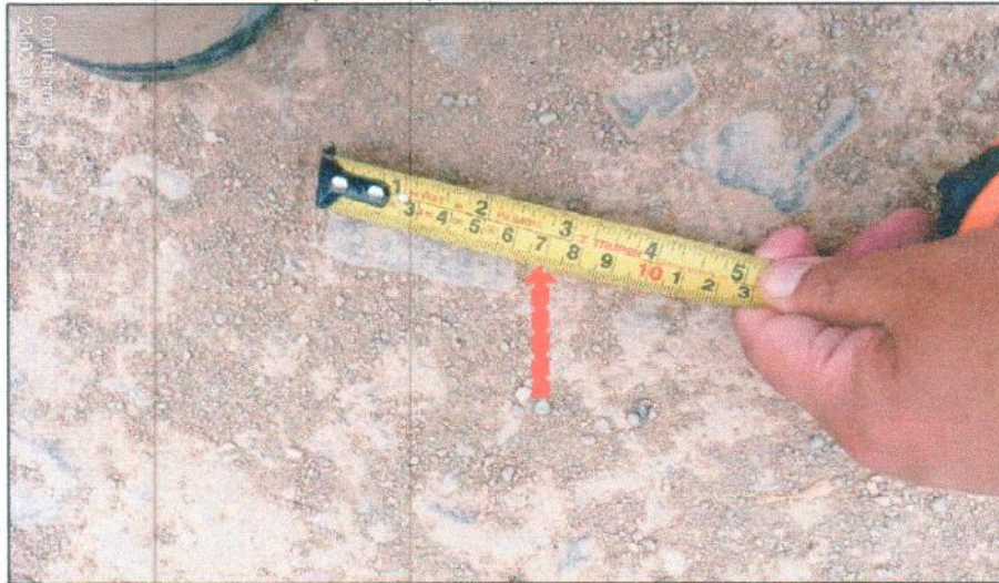
FOTOGRAFIA N° 34 EMP. PE-1N (HUARMEY) - LECHERAL - CUZCUZ - EMP. AN-109
