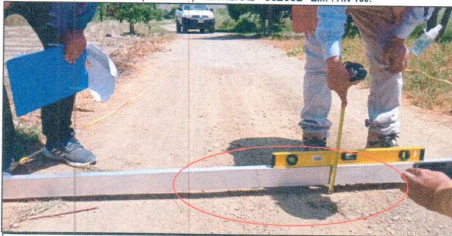
FOTOGRAFIA N° 12 EMP. PE-1N (HUARMEY) - LECHERAL - CUZCUZ - EMP. AN-109.
