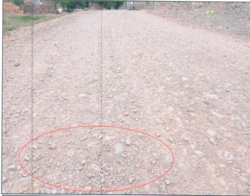
FOTOGRAFIA N° 13 EMP. PE-1N (HUARMEY) - LECHERAL - CUZCUZ - EMP. AN-109.
