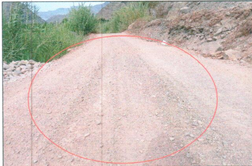
FOTOGRAFIA N° 27 EMP AN 109. PUENTE CUZCUZ - PUENTE MANDINGA
