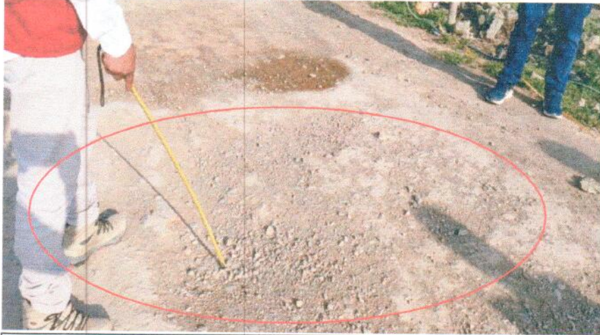
FOTOGRAFIA N° 15 EMP. PE-1N (HUARMEY) - LECHERAL - CUZCUZ - EMP. AN-109.
