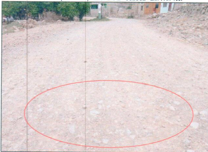
FOTOGRAFIA N° 14 EMP. PE-1N (HUARMEY) - LECHERAL - CUZCUZ - EMP. AN-109.
