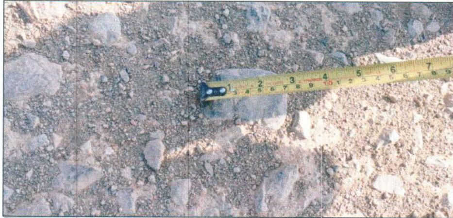
FOTOGRAFIA N° 31 EMP. PE-1N (HUARMEY) - LECHERAL - CUZCUZ - EMP. AN-109.
