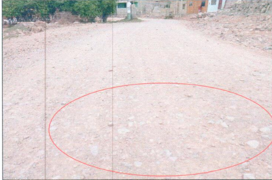
FOTOGRAFIA N° 33 EMP. PE-1N (HUARMEY) - LECHERAL - CUZCUZ - EMP. AN-109.
