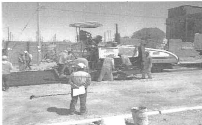
Fig 1. EXTENDIDO Y COMPACTADO DE MEZCLA ASFALTICA EN FRIO EN CALLE H CUADRA 4
