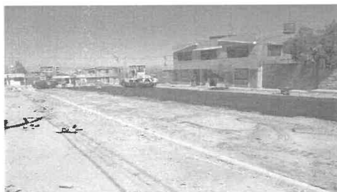
Fig 9. EXTENDIDO Y COMPACTADO DE MEZCLA ASFALTICA EN FRIO EN CALLE J CUADRA 4
