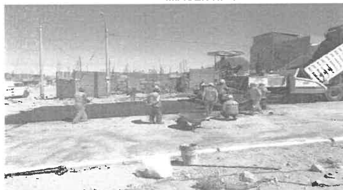
Fig 7. EXTENDIDO Y COMPACTADO DE MEZCLA ASFALTICA EN FRIO EN CALLE G CUADRA 2
