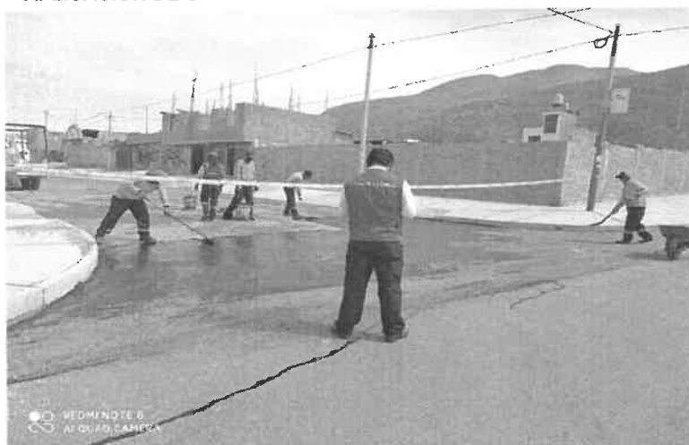
IMAGEN N° 16 APLICACIÓN DE SELLO ASFÁLTICO POR PARTE DEL CONTRATISTA
