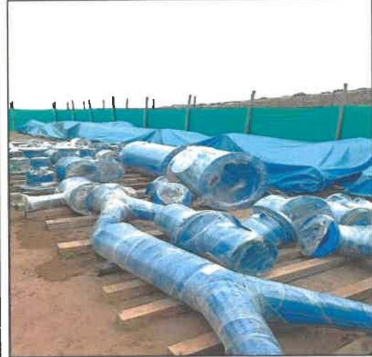
Imagen n.º 5: Se procedió al internamiento de los manifold sobre tarimas en el patio del campamento de obra.
