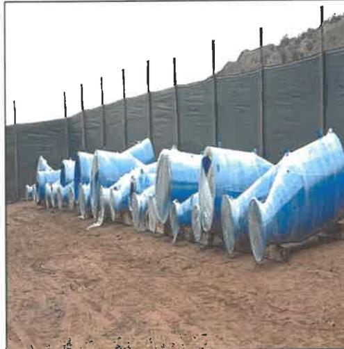
Imagen n.º 4: Se procedió al internamiento de los manifold sobre tarimas en el patio del campamento de obra.
