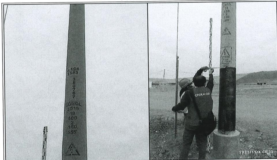
Se observa que la altura desde la base del poste hasta la señalización es de 3 m. (marcado en bajo relieve) y la altura desde el piso terminado hasta la señalización antes referida en este caso es de 1.91 m. Por lo que la altura de cimentación es de: 3 m. - 1.91 m. = 1.09 m., lo que no cumple los 1.70 m. establecido en los planos, y tampoco los 1.6 m. establecido en las especificaciones técnicas.
