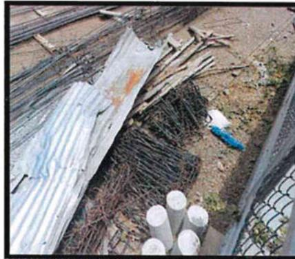
**Comentario:** Varillas y estribos de acero apoyadas directamente sobre el suelo presentan oxidación.
