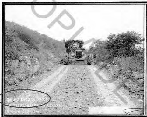
Foto 7. Extendido de material granular afirmado HERRERA VALENZUELA INGENIERO CIVIL
