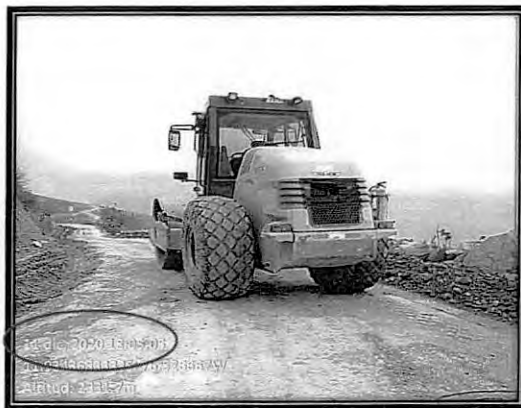
Foto 9. Compactación de material granular afirmado. GUILLERMO MANUEL HERRERA VALENZUELA, INGENIERO CIVIL, Reg. CIP N° 40014
