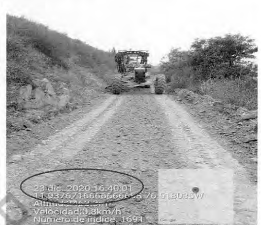
Foto 7. Extendido de material granular afirmado HERRERA VALENZUELA INGENIERO CIVIL
