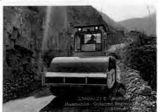
Foto 4: Compactación de carpeta de rodadura – Tramo 2
