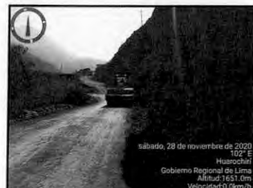
Foto N.º 02: Compactación de carpeta de rodadura
