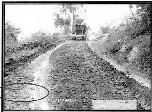
Foto 6. Reconformación de cunetas
