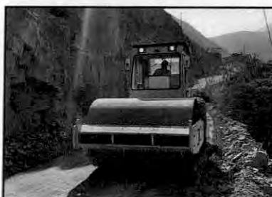
Foto N.º 04: Compactación de carpeta de rodadura
