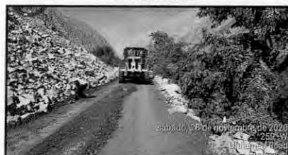
Foto N.º 01: Conformación de carpeta con Alfamado
