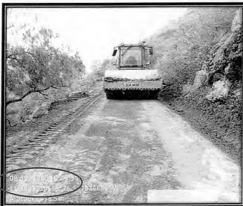
Foto 8. Compactación de material granular afirmado.
