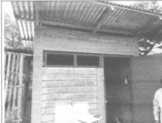
**Fotografía n.º 31:** En la localidad de Churgar, en la UBS de propiedad de Aurelio Álvarez Muñoz, durante la inspección física se advirtió ventana de madera con diseño distinto al previsto en expediente técnico, además que no cuenta con vidrio.
