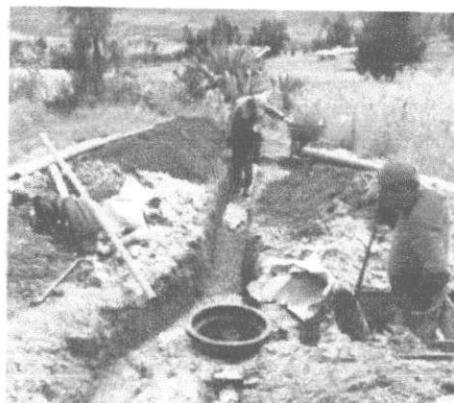
Imagen n.º 28: Extraída de la valorización del adicional, se advierte trabajadores realizando labores en zanjas de infiltración, no cuentan con casco, guantes ni chaleco.
