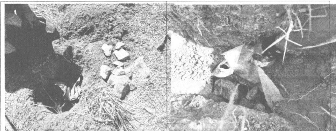
**Fotografía n.º 41:** En la localidad de Tinajones, en la UBS n.º 4 de propiedad de Yolanda Mendo Cerdán, el material filtrante de zanja de infiltración presenta piedra de chacra mayor a 2".
