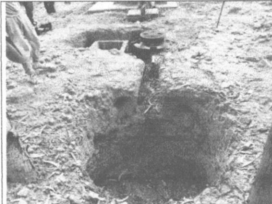
**Fotografía n.º 29:** En la localidad de Dos de Mayo, en la UBS de del señor Alipio Muñoz Leyva, durante la inspección física se advirtió la falta de ejecución de la zanja de infiltración o pozo percolador.
