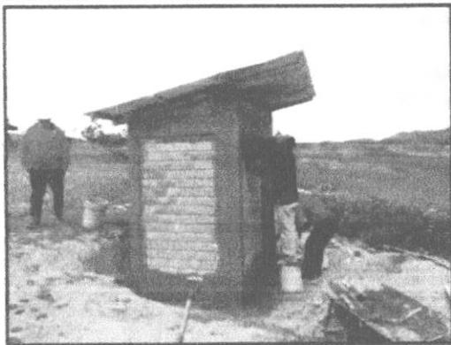
Imagen n.º 25: Extraída de la valorización n.º 3, se advierte trabajadores realizando labores de tarrajeo en exteriores, no cuentan con casco, guantes ni chaleco.
