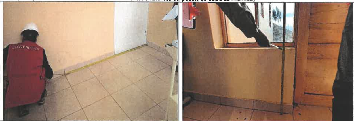
Se observa contrazocalo de cerámico de 10x45cm en los diferentes ambientes del puesto de salud de Aranhua
