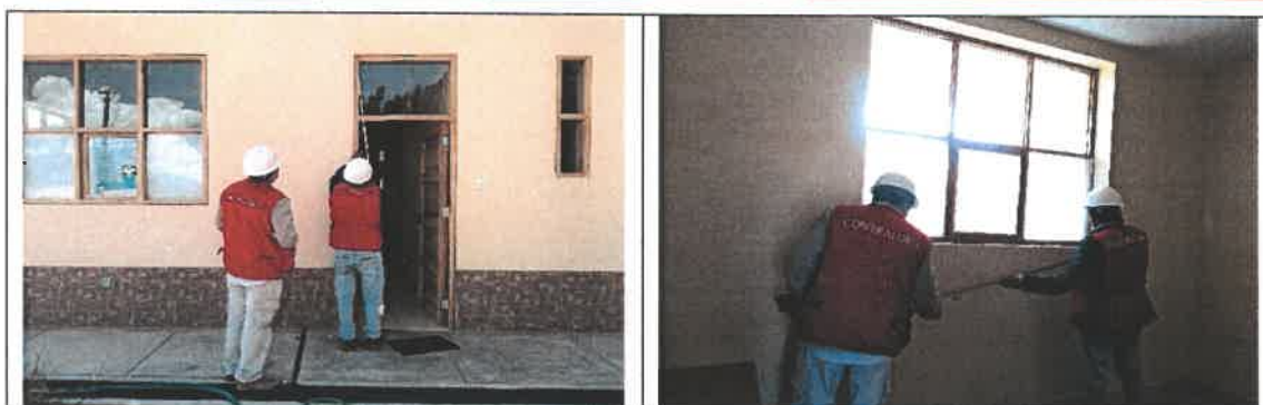
Ventana de madera, 5 hojas fijas, 1 hoja móvil (con bisagra), vidrio simple transparente de espesor de 3mm.
