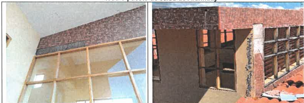
Se observa desprendimiento de fachaleta debido a que no se ejecutó según lo establecido en el expediente técnico
