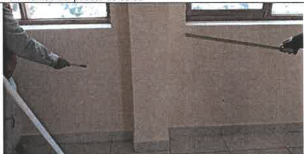
Se observa fisuras y rajaduras transversales y horizontales en muros en ambientes del puesto de salud
