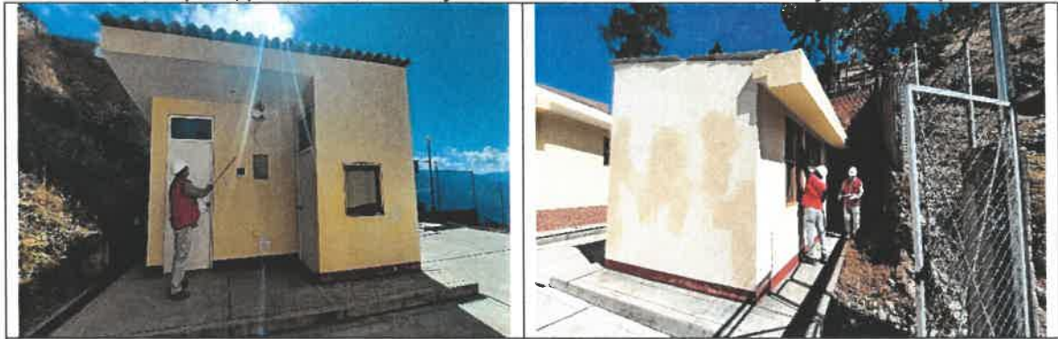
Contrazocalo con Esmalte de color rojo de altura =0.15\text{m} .
