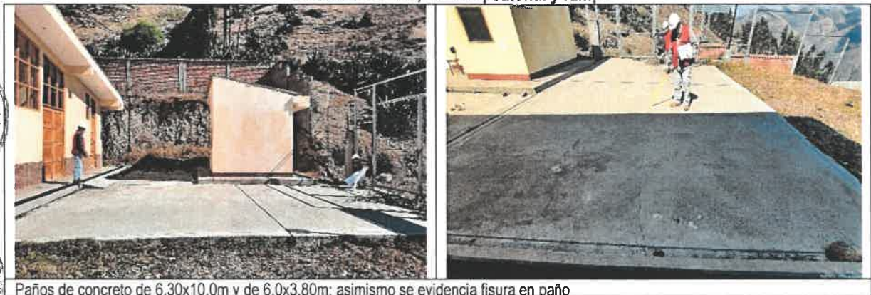
Paños de concreto de 6.30 \times 10.0\text{m} y de 6.0 \times 3.80\text{m} ; asimismo se evidencia fisura en paño
