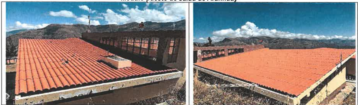
Imágenes n. ros 84 y 85 Modulo puesto de salud de Aranzhuay
