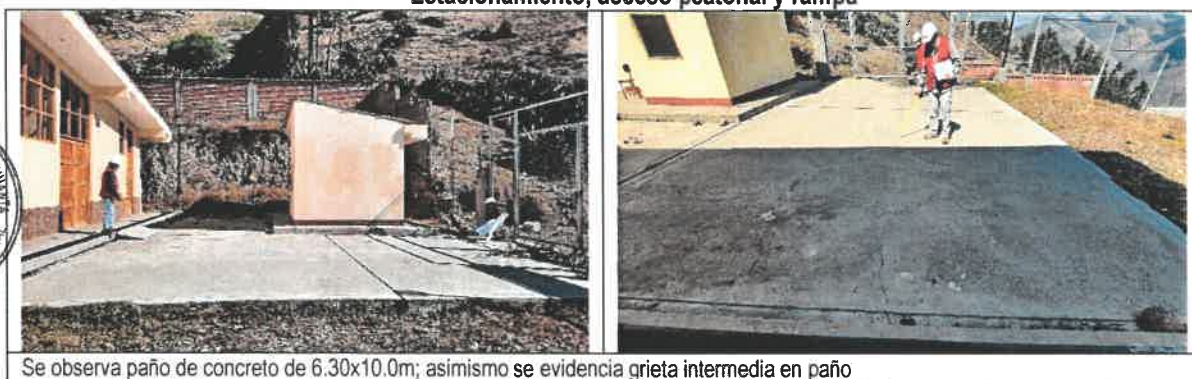
Imágenes n.°s 86 y 87 Estacionamiento, acceso peatonal y rampa
