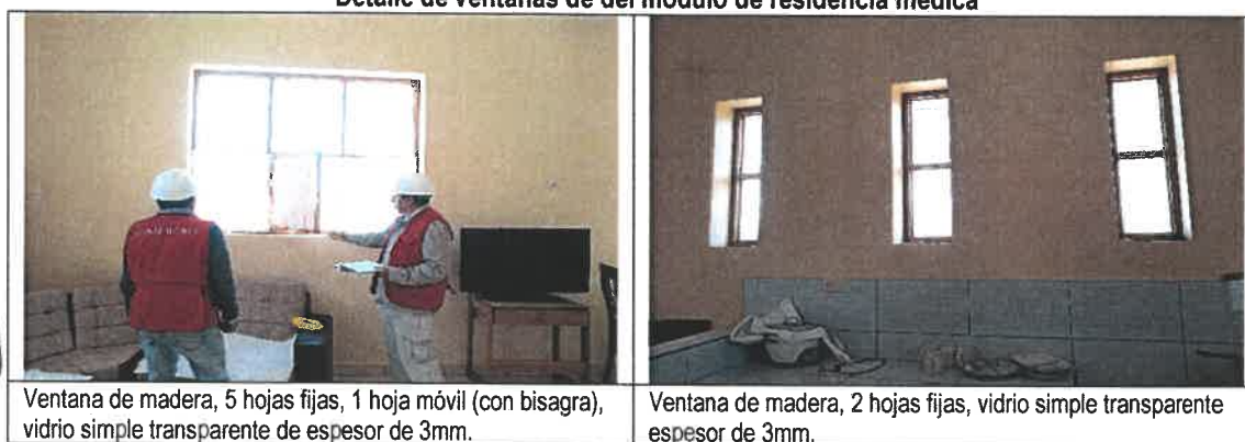
Imágenes n.ºs 29, 30, 31 y 32 Detalle de ventanas de del módulo de residencia médica
