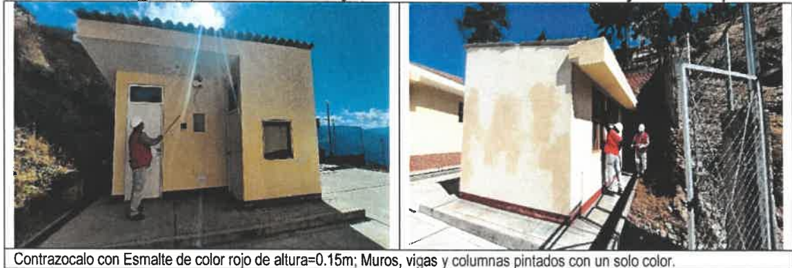
Contrazocalo con Esmalte de color rojo de altura=0.15m; Muros, vigas y columnas pintados con un solo color.
