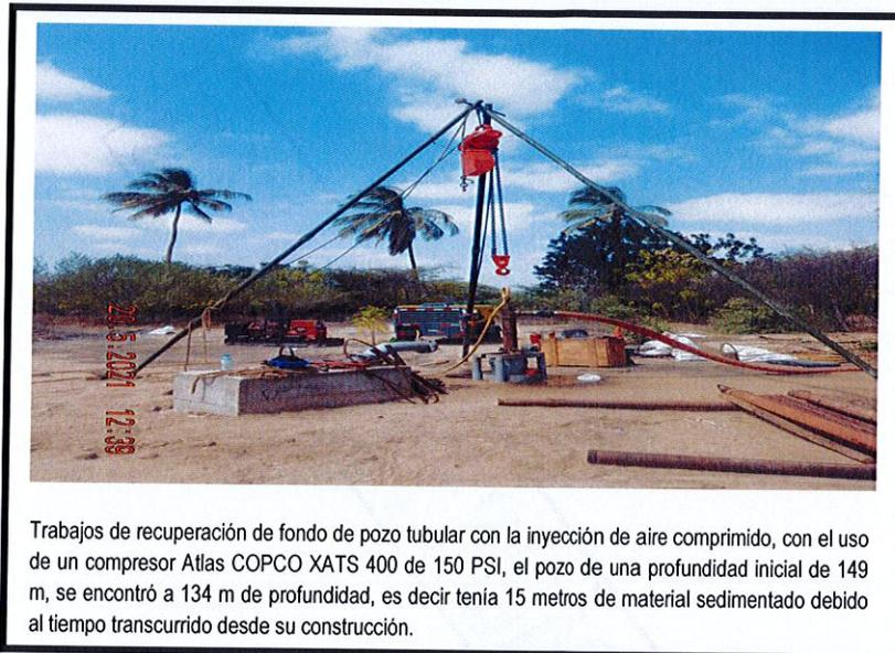
Se puede indicar que, de acuerdo a esta visita, se verificó que el pozo había perdido una profundidad de 15 metros, producto de la sedimentación, por el desuso del pozo tubular, que se trataría de recuperar con la inyección de aire comprimido y el uso de aditivos como tripolifosfato, que removerán los estratos sedimentados en el fondo del pozo, para luego sacar el material mediante la inyección de aire comprimido.
