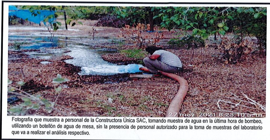
Fotografía que muestra a personal de la Constructora Única SAC, tomando muestra de agua en la última hora de bombeo, utilizando un botellón de agua de mesa, sin la presencia de personal autorizado para la toma de muestras del laboratorio que va a realizar el análisis respectivo.
