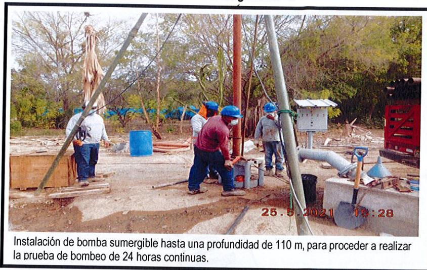
Instalación de bomba sumergible hasta una profundidad de 110 m, para proceder a realizar la prueba de bombeo de 24 horas continuas.
