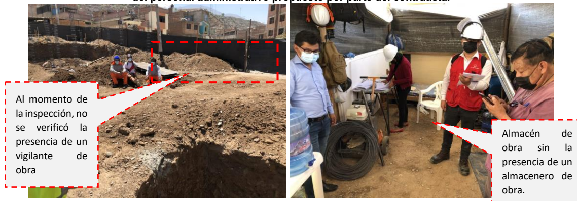
Imagen n.º 1, 2 y 3 Trabajos Realizados sin la presencia del personal administrativo propuesto por parte del contratista.
