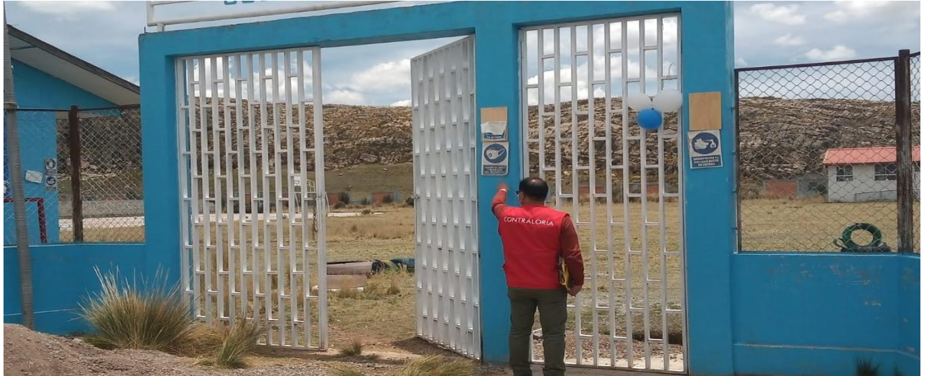
Carteles de señalización en la entrada del aula de la I.E. n.° 34106, situado en el Jr. Ayacucho s/n, en el Centro poblado de Cochamarca, distrito de Vicco, provincia y departamento de Pasco.
