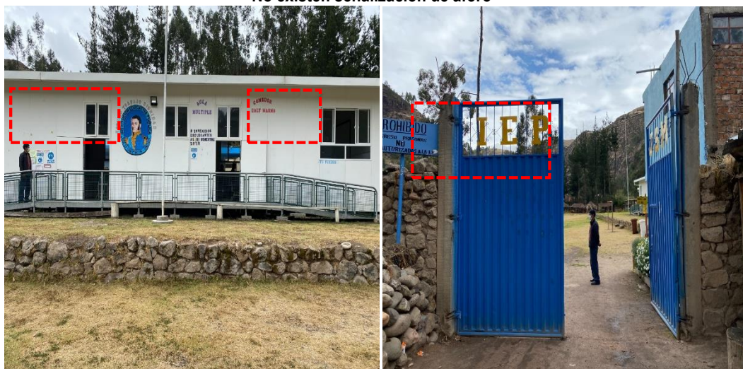
Imagen n.° 5 No existen señalización de aforo
