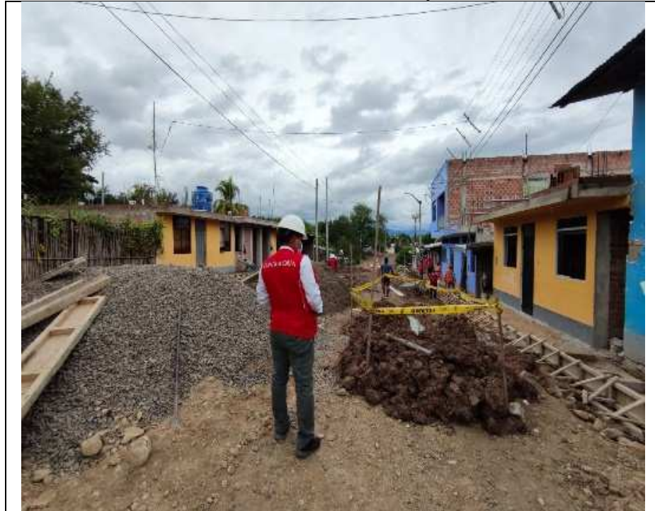
Imagen n.º 28 Encofrado de veredas verificadas el 17 de junio de 2021
