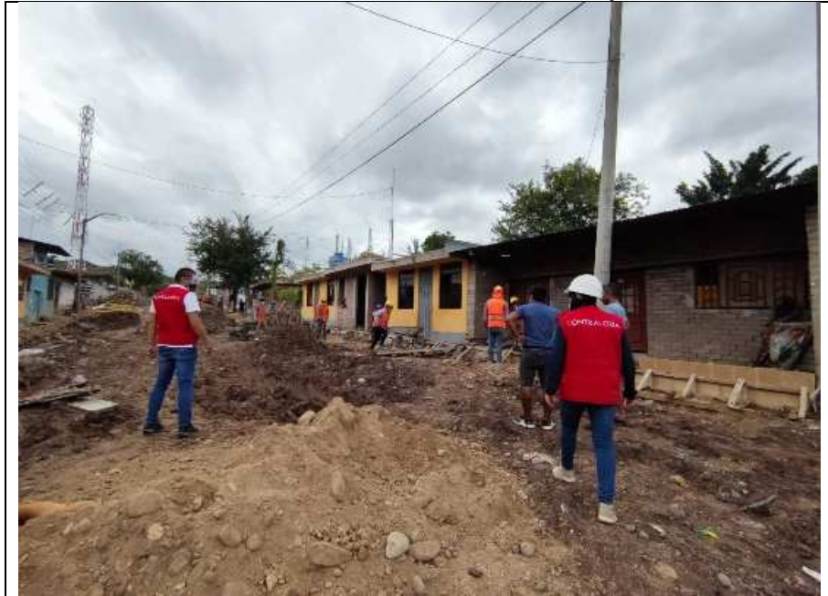
Imagen n.º 24 Colocación de afirmado en veredas verificadas el 17 de junio de 2021.
