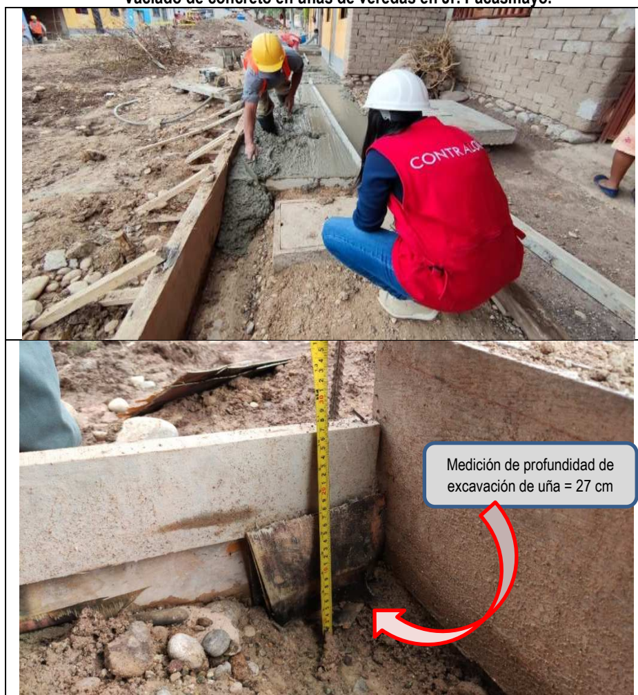
Imagen n.º 21 Vaciado de concreto en uñas de veredas en Jr. Pacasmayo.
