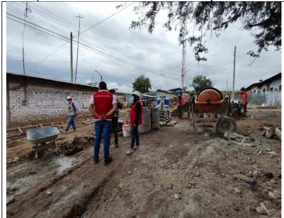
Imagen n.º 25 Preparación de concreto en veredas verificadas el 17 de junio de 2021.
