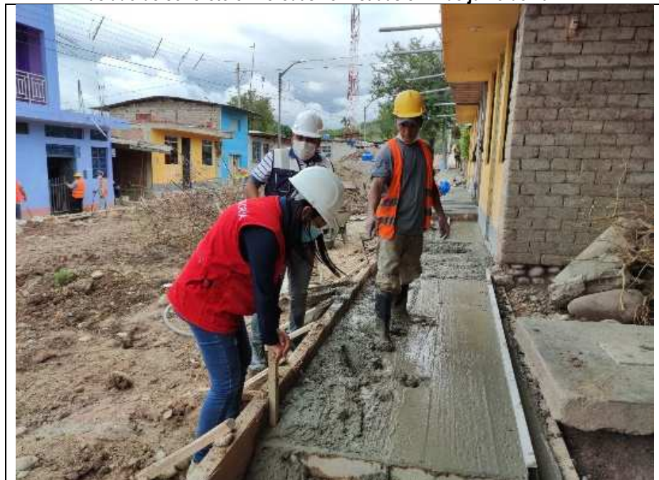
Imagen n.º 29 Vaciado de concreto en veredas verificadas el 17 de junio de 2021
