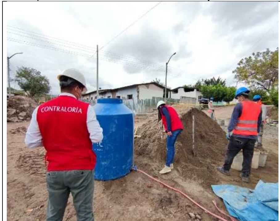
Imagen n.º 26 Preparación de concreto en veredas verificadas el 17 de junio de 2021.
