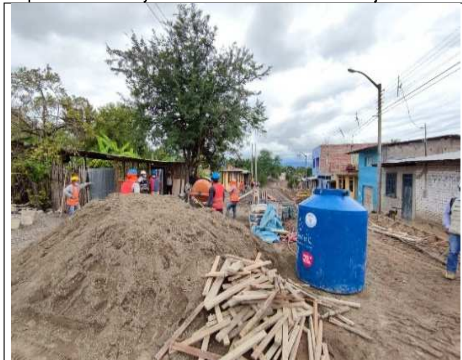
Imagen n.º 27 Preparación de concreto y encofrado de veredas verificadas el 17 de junio de 2021.
