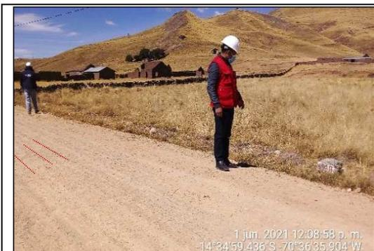
**Imagen n.º 8:** Ahuellamientos sobre el afirmado con apariencia de encalaminado.
