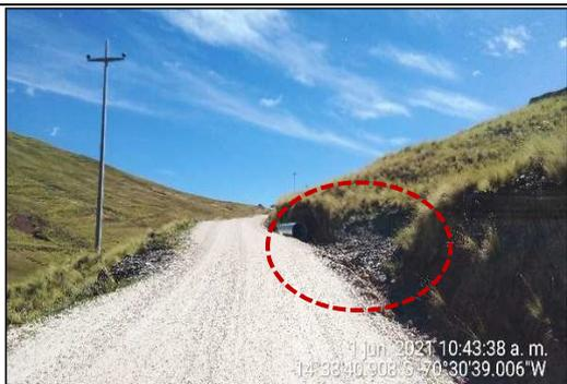
**Imagen n.º 10:** Ahuellamientos con apariencia de encalaminado y material de derrumbe sobre cuneta.
