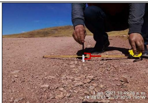
**Imagen n.º 9:** Ahuellamientos con hundimientos de 4 cm.
