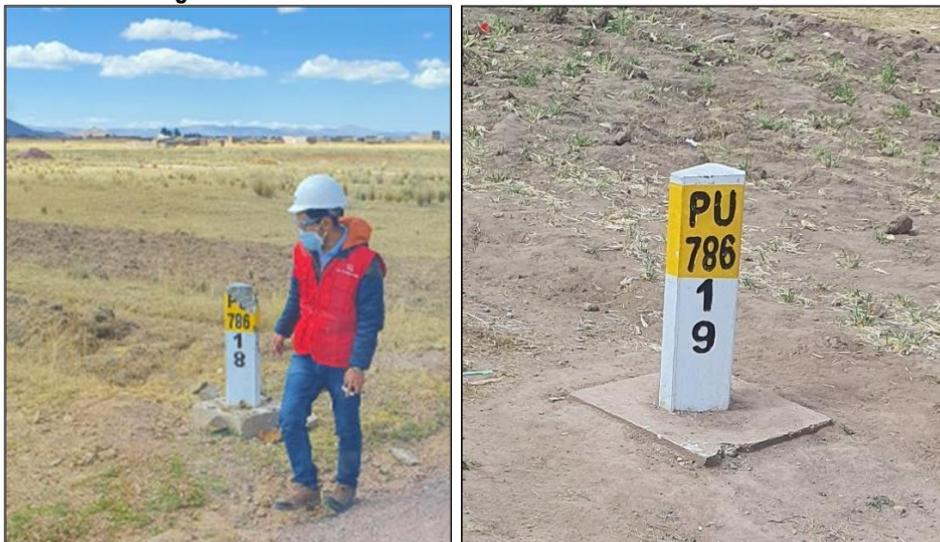
**Comentario:** Se evidencia la instalación de los postes kilométricos, de los cuales el poste kilométrico de la progresiva Km 18+000 presenta daños.
