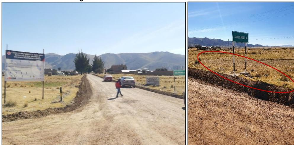
**Comentario:** Se evidencia la falta de la instalación del poste kilométrico de la progresiva Km 0+000.
