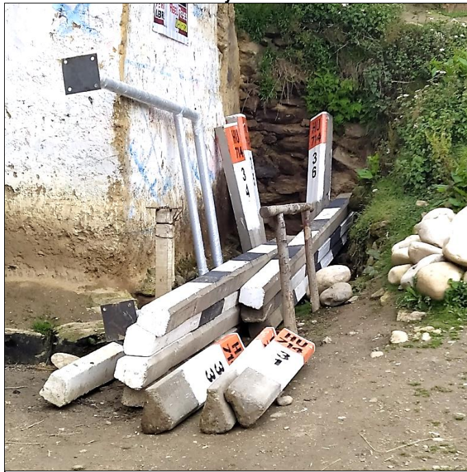
Fotografía n.º 19 Progresiva 00+500 - Se observa hitos kilométricos y parantes para señales preventivas ubicadas en el pueblo de Gorgor.
