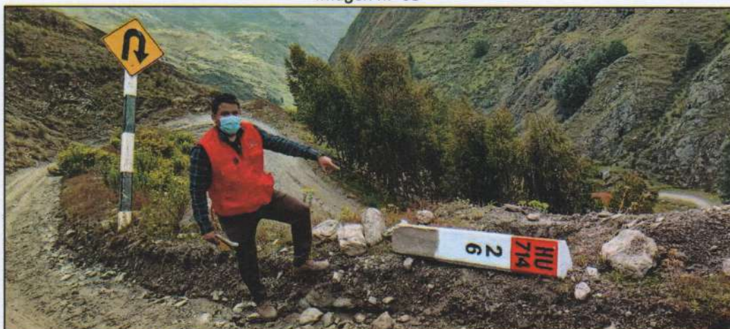
6+000 - Se observó hito kilométrico al lado de la vía, asimismo pudo apreciarse la excavación para su colocación.
