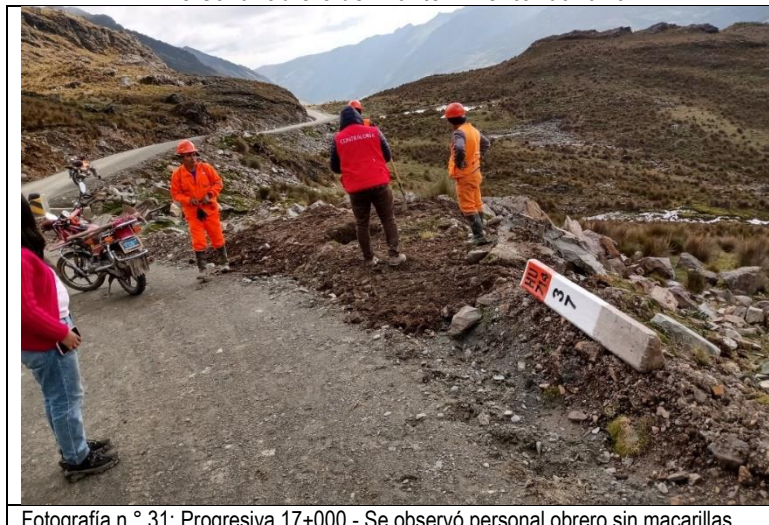
Fotografía n.º 31: Progresiva 17+000 - Se observó personal obrero sin macarillas.
