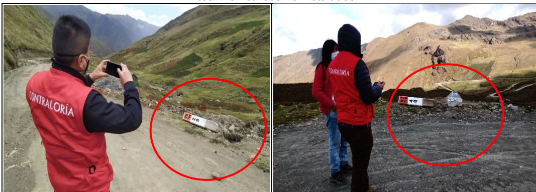
Fotografía 25: Progresiva 9+000 - Se observó hito kilométrico al lado de la vía, asimismo pudo apreciarse la excavación para su colocación
