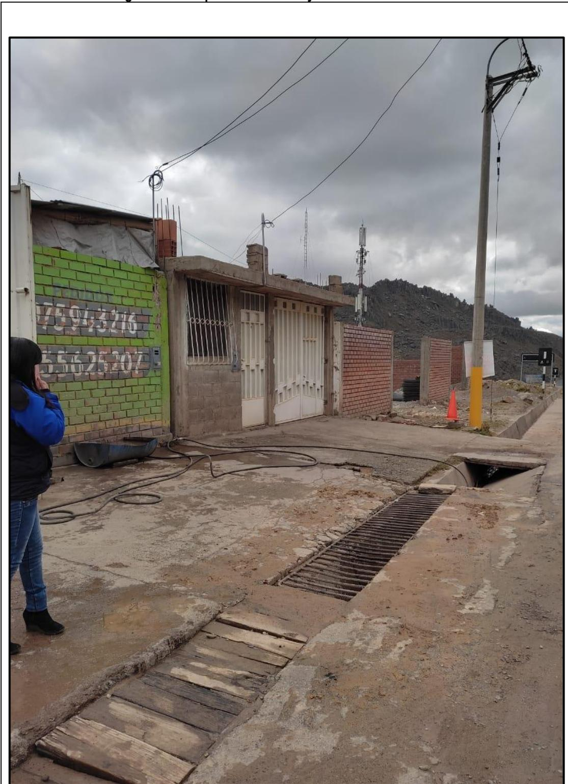
Zona de vertido de los efluentes resultantes del proceso de lavado de los vehículos recolectores, el cual no se encuentra acondicionada para tal fin.
