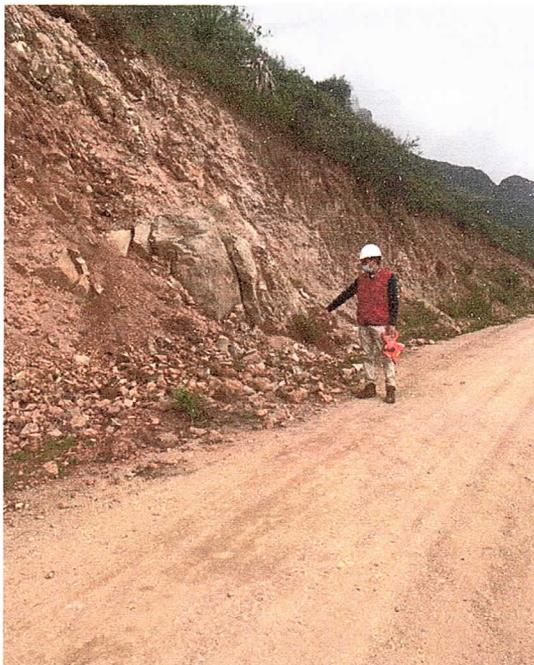
Se observó el desprendimiento de rocas y material granular entre la progresiva 8+250 y 8+300.
