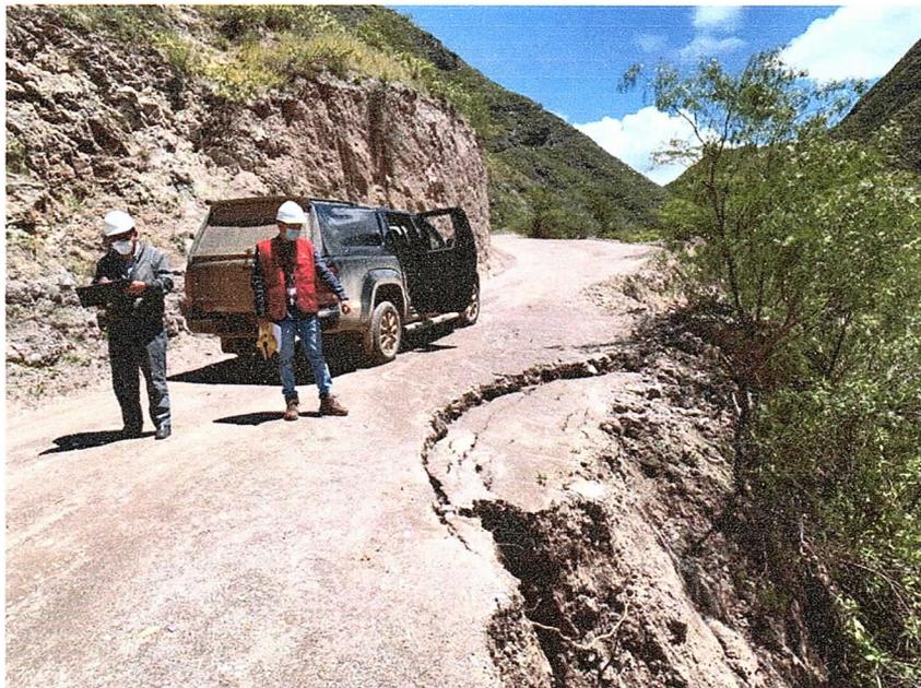
Se observó un tramo de vía a punto de colapsar en la progresiva 6+390
