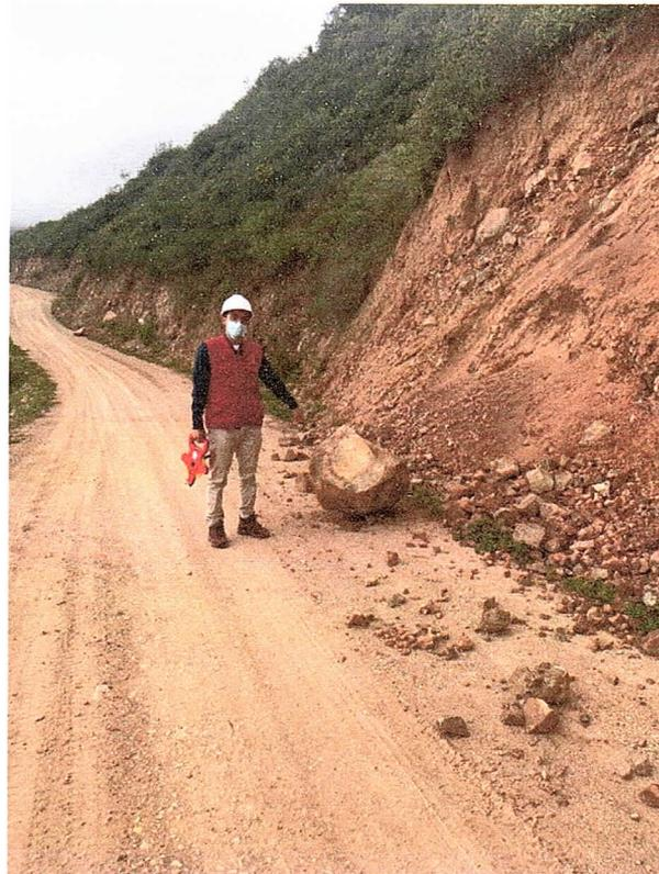
Se observó el desprendimiento de rocas y material granular entre la progresiva 8+250 y 8+300.
