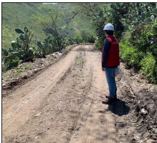
**Fotografía n.º 4:** Afirmado con material con deficiente compactación, progresiva 5+720.
