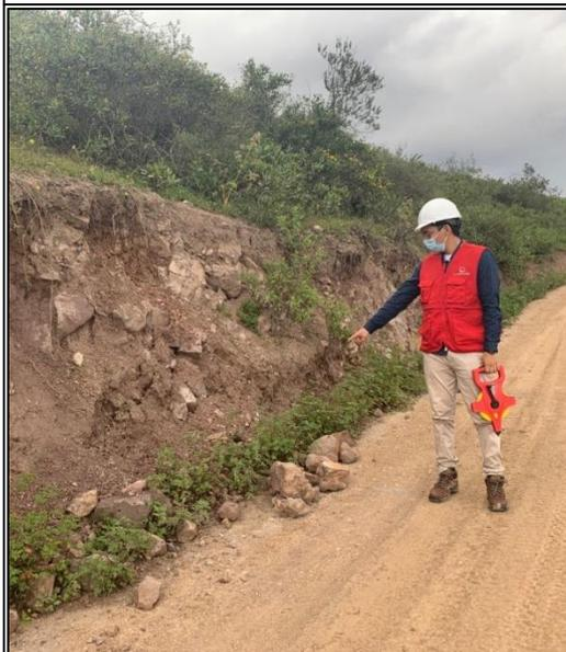
**Fotografía n.° 8:** Desprendimiento de rocas y material granular (derrumbes) sobre las cunetas, progresiva 0+800
