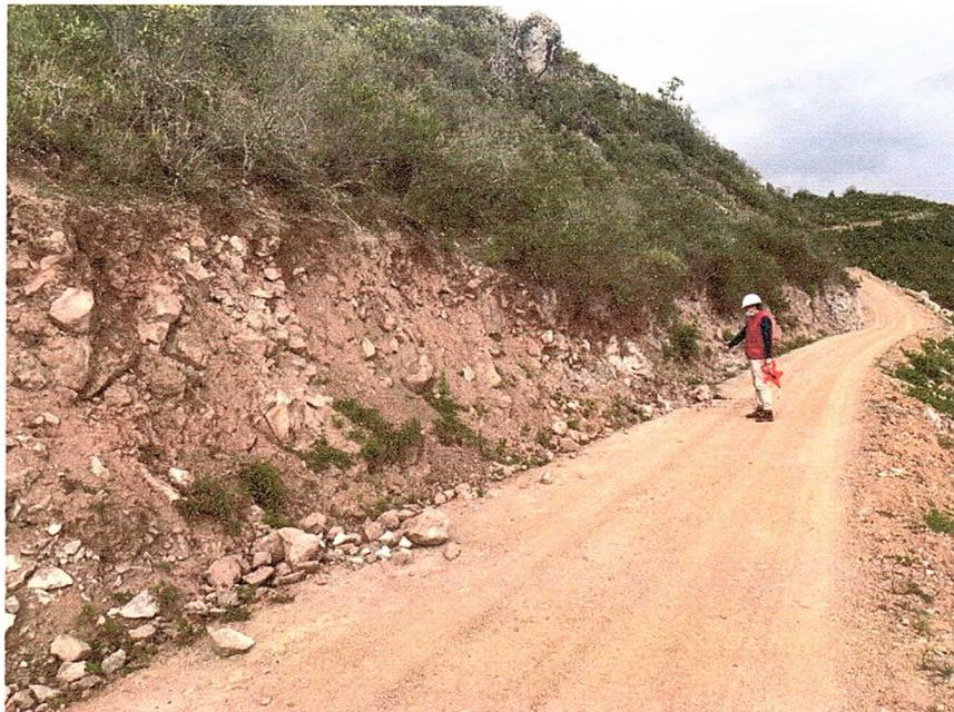
Se observó el desprendimiento de rocas y material granular en la progresiva 1+700.
