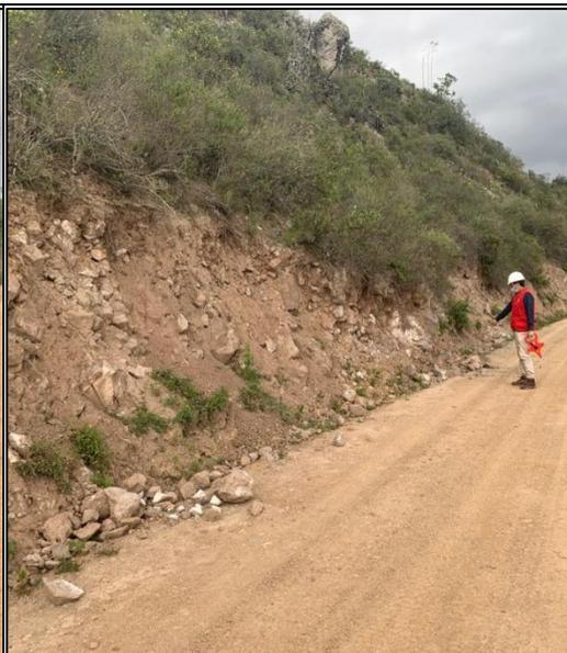
**Fotografía n.° 9:** Desprendimiento de rocas y material granular (derrumbes) sobre las cunetas, progresiva 1+700
