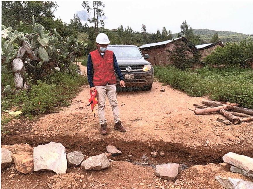
Se encontró un canal que atraviesa la superficie de rodadura en la progresiva 1+900.
