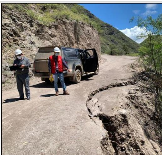
Fotografía n.º 5: Tramo de vía a punto de colapsar, progresiva 6+390
