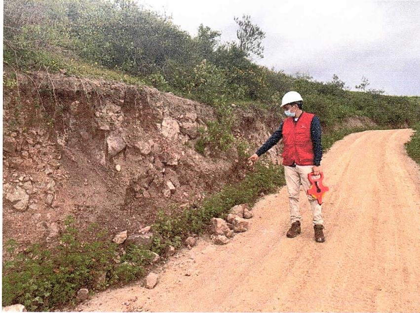
Se observó el desprendimiento de rocas y material granular en la progresiva 0+800.
