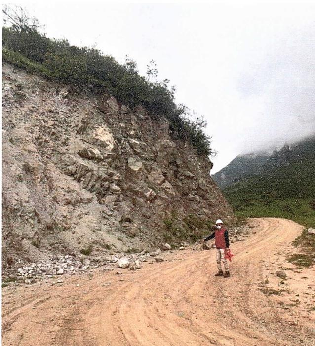
Se observó el desprendimiento de pequeñas rocas y material granular en la progresiva 6+460.
