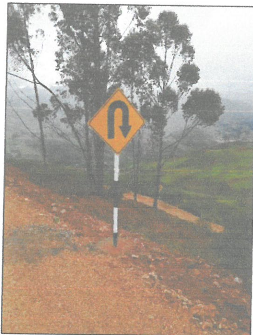
Verificación de la existencia de las señales preventivas
