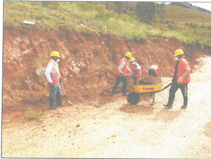
Presencia de personal trabajando en los caminos vecinales km 6+700
