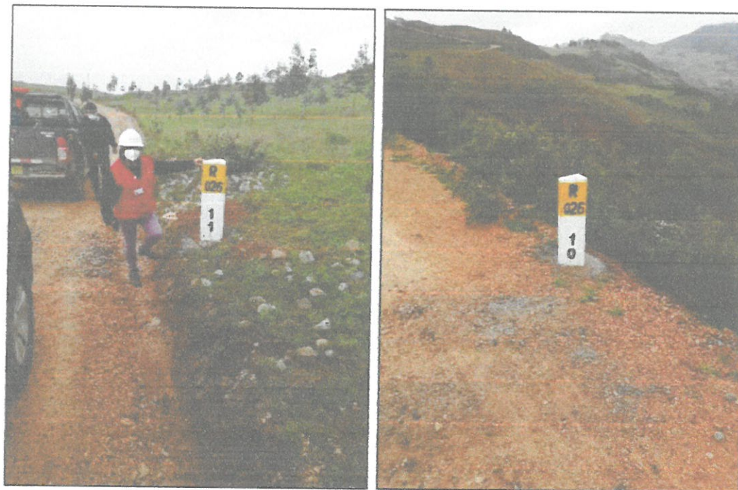
Verificación de la colocación de los hitos kilométricos
