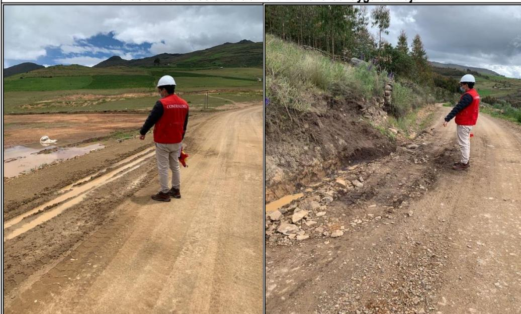
**Fotografía n.º 1.** Progresiva km 0+030. Ahuellamientos y empozamiento de agua al borde de la vía.
