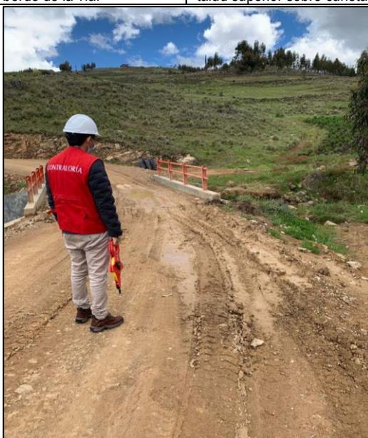
**Fotografía n.º 3,** Progresiva km 4+050. Ahuellamientos en la superficie de rodadura, por la saturación de capa de afirmado.
