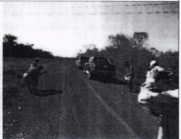
**Fotografía N° 3:** se puede apreciar que a partir de la progresiva 8+200 el tramo se encuentra totalmente cubierto de vegetación
