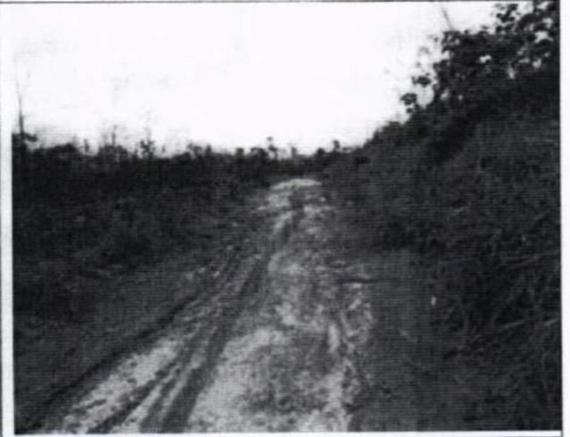
Fotografía N° 3: se puede apreciar que el tramo no cuenta con cunetas laterales, plataforma cubierto de vegetacion y laterales con vegetación
