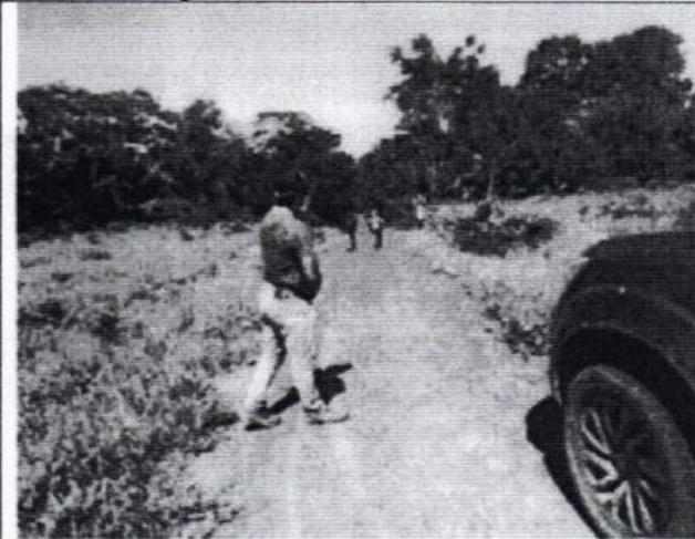
**Fotografía N° 4:** Estado actual del Camino Vecinal, en el cual se puede apreciar la plataforma cubierta de vegetación y ausencia de cunetas laterales
