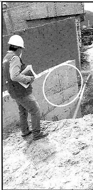
Fotografía n.º 14: Se observa cangrejas en muro de contención ubicada en la progresiva 1+800.
