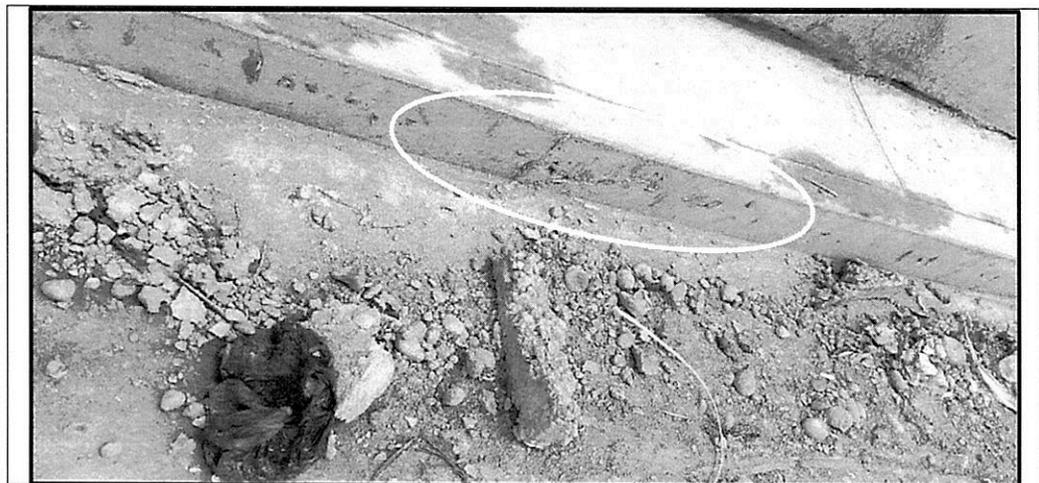
Fotografía n.º 8: Se observa veredas de concreto de  $F'c=175$  kg/cm<sup>2</sup> con presencia de cangrejas en la progresiva 2+400.
