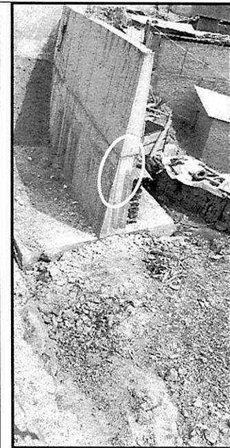
Fotografía n.º 13: Se observa cangrejas en muro de contención ubicada en la progresiva 1+730.
