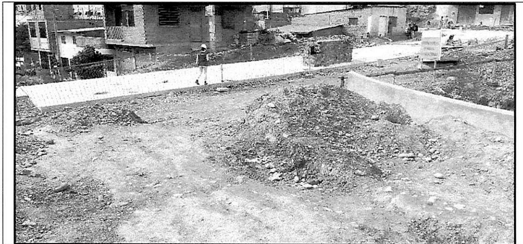
Fotografía n.º 23: Se observa desmonte de tierra sobre la losa maciza del puente via crucis
