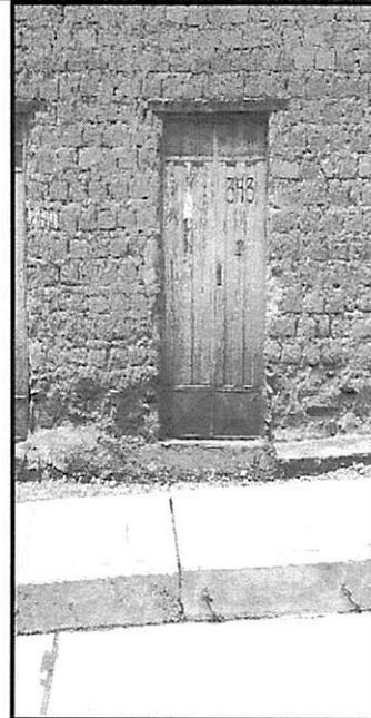
Fotografía n.º 10: Se observa veredas de concreto de  $F'c=175$  kg/cm<sup>2</sup> con presencia de cangrejas en la progresiva 2+600.
