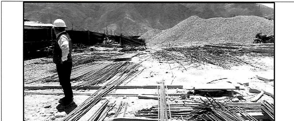
**Fotografía n.º 3:** Durante la visita se observó la que las barras de acero se encuentran en la intemperie sin ningún tipo de recubrimiento, así como también la falta de limpieza y orden en obra.
