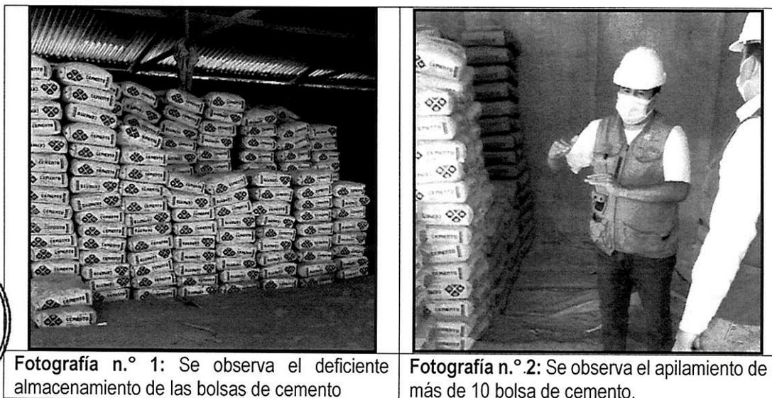
**Fotografía n.º 1:** Se observa el deficiente almacenamiento de las bolsas de cemento
