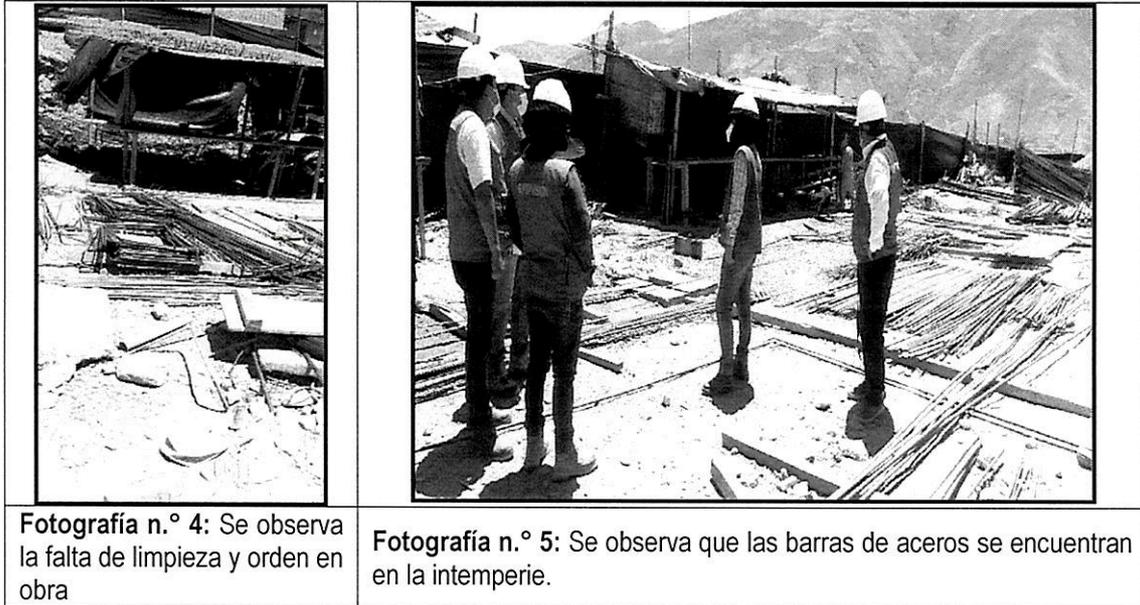
Fotografía n.º 4: Se observa la falta de limpieza y orden en obra
