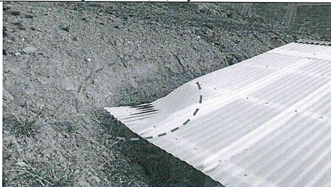
Techo del lecho de secado de la PTAR de Colpar Imágenes n.ºs 18, 19, 20 y 21
