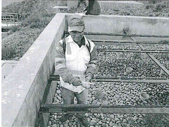
En la imagen n.º 16, se observa la medición de las piedras en uno de los filtros biológicos de la PTAR.
