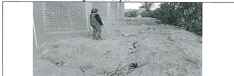
En la imagen n.º 25, se observa las grietas del terreno en la parte externa de la PTAR.
