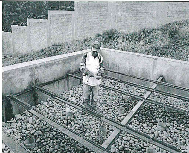
En la imagen n.º 17, se observa la medición de las piedras en otro de los filtros biológicos de la PTAR..
