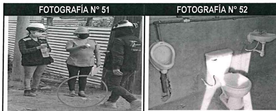
En la fotografía n.° 52, se observa que no se completó la instalación del urinario y ducha en los servicios higiénicos de la PTAR.
