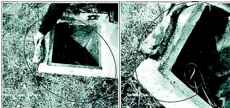
*Vista N° 9: Rotura y desprendimiento de concreto simple en bordes exteriores e interiores de caja de pase eléctrico instalados.*
