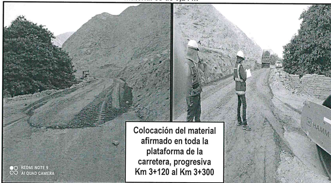
Imagen N° 4 Ejecución de partidas en toda la plataforma de la carretera, cuya altura de colocación del material es de 0,24 m
