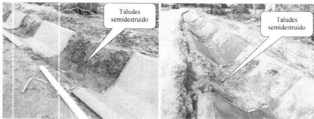
Canal de riego Clake, se observa que los taludes intermedios se encuentran destruidos, y, son rellenados y apisonados con palana antes de colocar el concreto. No existe control de calidad para verificar que el grado de compactación en los taludes está de acuerdo a las especificaciones técnicas.
