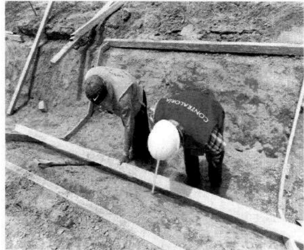
Imagen n.º 11: Verificando el espesor para el vaciado de concreto en los taludes de canal, constatándose espesores de 5.50 centímetros.
