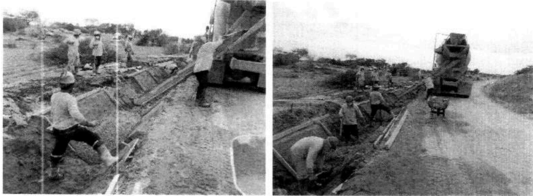
Imagen n.º 17: Verificando en el canal de riego Clake, que en el vaciado de concreto no utilizan el Minicargador bobcat 70 HP, 0.5 Yd 3 .
