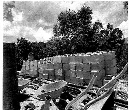
**Fotografía n.º 8:** Cajas de concreto domiciliarias para desagüe apiladas.
