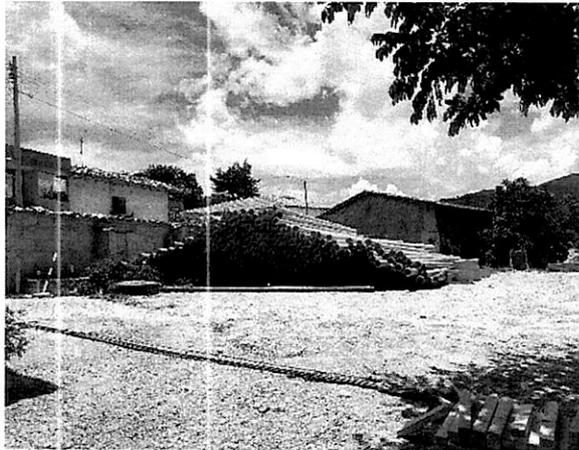
**Fotografía n.º 7:** Tubería PVC desagüe de 6", apilada inadecuadamente y a la intemperie.
