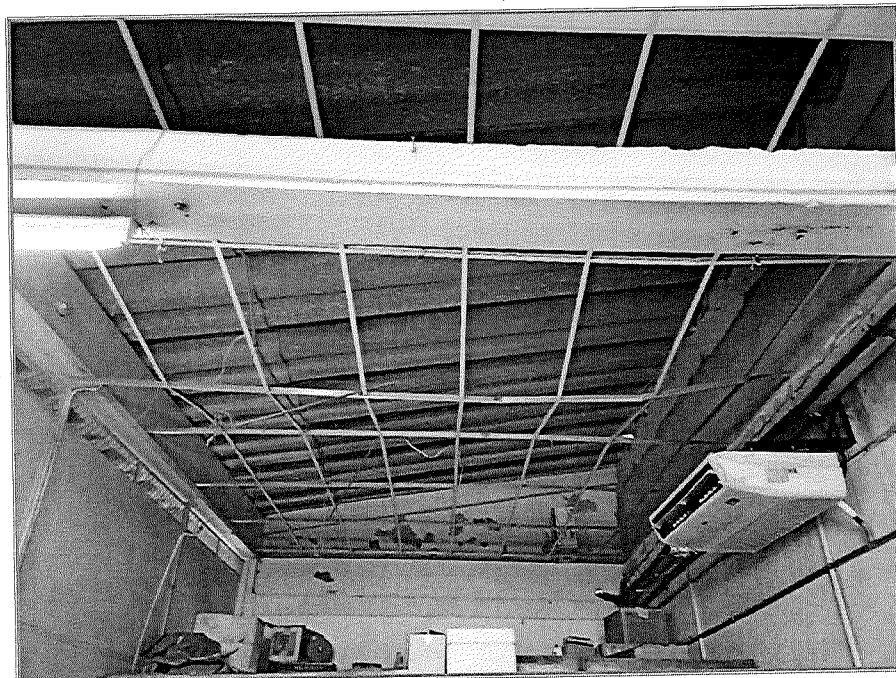
Fotografía 8: Techo del área de despacho del almacén de vacunas.
