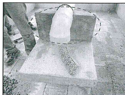
FOTOGRAFÍA N° 5 LA LOSA DE ESPARCIMIENTO SOLO TIENE UN MURO
