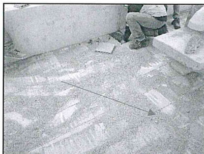
FOTOGRAFÍA N° 4 SE MUESTRA LOS LADRILLOS TIPO PASTELERO QUE ESTÁN ENCIMA DE LA ARENA GRUESA
