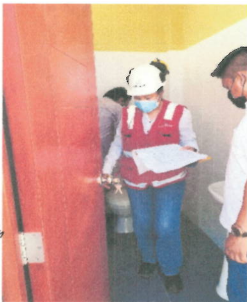
Fotografías n.°s 2 y 3.- En los dos servicios higiénicos se encontró puertas contraplacadas, mientras que en resto de puertas son macizas. Todas las puertas instaladas abren hacia el interior de los ambientes.
