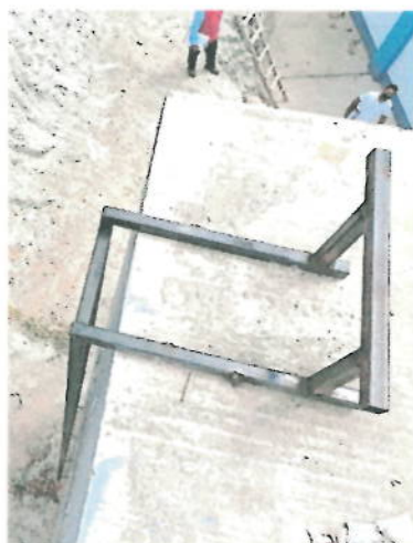
Fotografías n.ºs 16 y 17.- Se advierte que la escalera de acceso hacia el tanque elevado no tiene estructura de protección, en la parte superior del tanque elevado no se encontró la tapa, se verifica trabajos inconclusos al interior del tanque y falta limpieza.
