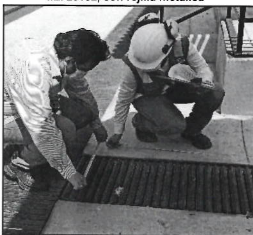
Fotografía n.o 7 Medición de la longitud de canaletas o cunetas en el piso de la I.E. 20182, con rejilla metálica
