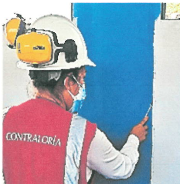
Fotografías n.ºs 8 y 9.- Falta mejorar la pintura en general y arreglo de trabajos de tarrajeo en general, especialmente en las juntas de dilatación que son menores a 1" de espesor. Es de precisar, que no se encontró equipamiento ni mobiliario al interior de la institución educativa.
