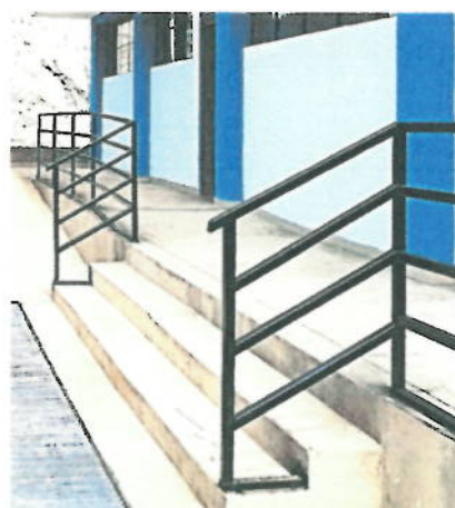
Fotografías n.ºs 14 y 15.- Escaleras exteriores e interiores sin cantonera
