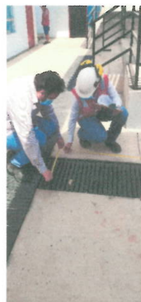
Fotografías n.ºs 10 y 11.- No se encontró la canaleta perimétrica en el piso (vereda) exterior del pabellón de aulas y pabellón de comedor-cocina y dirección. Se midió 56,35ml de canaleta de 50cm de ancho. Además, se verifica la construcción de rampa y escalera para acceso a aulas con barandas metálicas de tubo cuadrado 1 ½" x 1 ½", construcción de un módulo de material noble de 7,62m x 5,20m con 3 ventanas altas de 1m de altura por 3,40m de largo y 1 ventana alta de 1m de altura por 2,10m de alto, con piso de porcelanato gris con contrazócalo. Dimensiones del pabellón de comedor con dirección y SS.HH.: 17,60m x 5,23m y pabellón de aulas: 17,86m x 5,14m.
