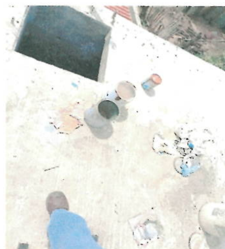
Fotografías n.ºs 16 y 17.- Se advierte que la escalera de acceso hacia el tanque elevado no tiene estructura de protección, en la parte superior del tanque elevado no se encontró la tapa, se verifica trabajos inconclusos al interior del tanque y falta limpieza.
