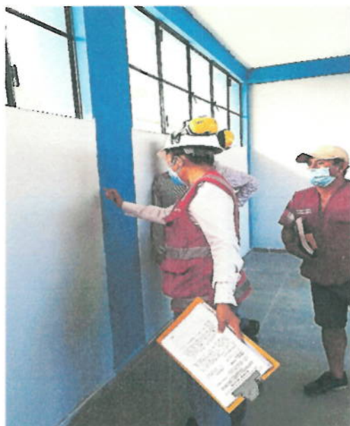
Fotografías n.ºs 8 y 9.- Falta mejorar la pintura en general y arreglo de trabajos de tarrajeo en general, especialmente en las juntas de dilatación que son menores a 1" de espesor. Es de precisar, que no se encontró equipamiento ni mobiliario al interior de la institución educativa.
