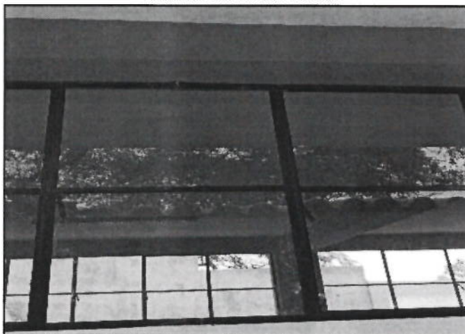
Fotografía n.º 10 Ventanas con vidrio crudo.
