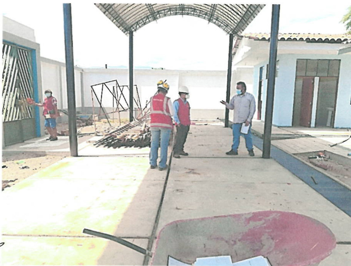
Fotografía n.º 20.- En el patio de formación se encontró sobrante de obra, la estructura del techo del patio está soportada por seis tubos metálicos de 6", vigas de hierro corrugado y cobertura metálica con planchas de color rojo. La losa es de concreto con juntas de dilatación cada dos paños y una junta longitudinal central, rellenas con asfalto. Falta limpieza general de obra.
