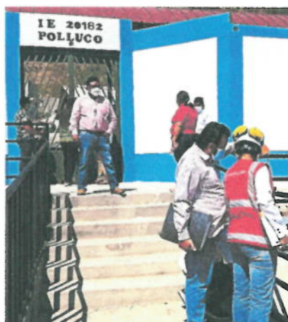
Fotografías n.ºs 14 y 15.- Escaleras exteriores e interiores sin cantonera
