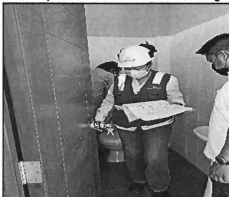
Fotografía n.º 3 Puerta contraplacada colocada en servicio higiénico
