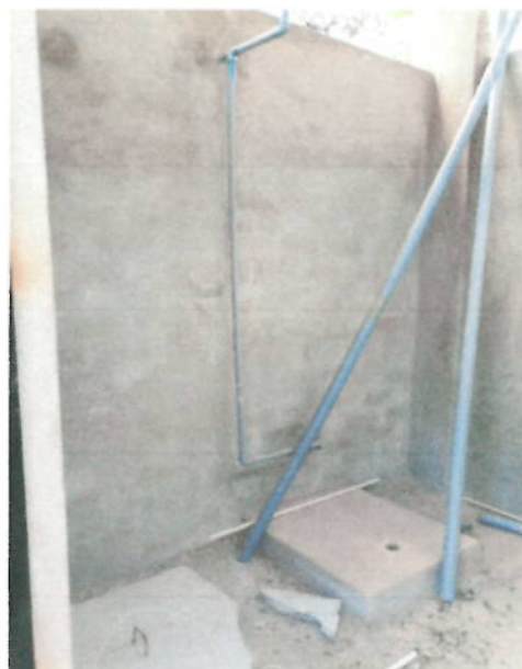
Fotografías n.ºs 18 y 19.- Se verificó que ni el tanque elevado ni la cisterna cuentan con el sistema de boyas ni con escaleras de acceso para ingresar al interior ni tienen tapas metálicas, no se ha instalado la tubería galvanizada, tampoco se encontraron las dos electrobombas, según plano Cortes y Elevaciones - Cisterna y Tanque, lámina CE-01. Además, los vanos para las ventanas altas de la infraestructura no tienen protección.
