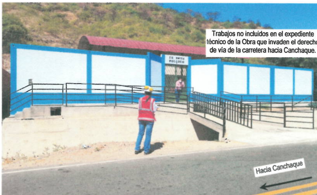
Fotografía n.° 1.- Fachada de la Institución Educativa N° 20182, en Polluco, no se encontró cartel de obra. Se verifica la construcción estructuras para el acceso hacia el colegio, como: muros de contención, rampas para discapacitados, baranda metálica perimetral de tubo cuadrado 1,5" x 1,5" de 1,03 m de alto; y, losa de concreto sobre una cuneta existente y dicha losa se conecta con la carpeta asfáltica de la carretera a Canchaque. Asimismo, no se encontró la construcción de las veredas exteriores laterales al cerco perimétrico.
