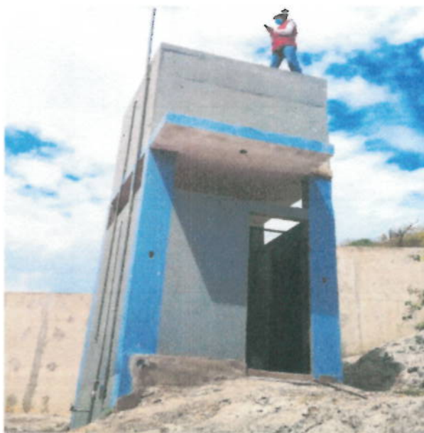
Fotografías n.ºs 18 y 19.- Se verificó que ni el tanque elevado ni la cisterna cuentan con el sistema de boyas ni con escaleras de acceso para ingresar al interior ni tienen tapas metálicas, no se ha instalado la tubería galvanizada, tampoco se encontraron las dos electrobombas, según plano Cortes y Elevaciones - Cisterna y Tanque, lámina CE-01. Además, los vanos para las ventanas altas de la infraestructura no tienen protección.
