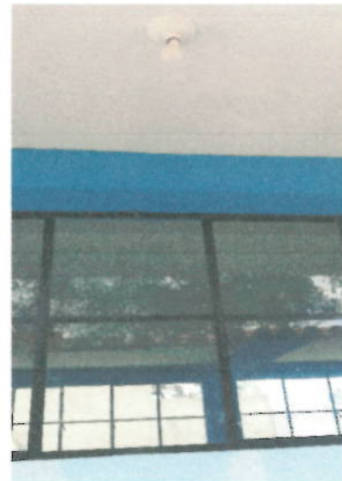
Fotografías n.º 4 y 5.- Los vidrios de todos los ambientes son crudos y no son laminados.
