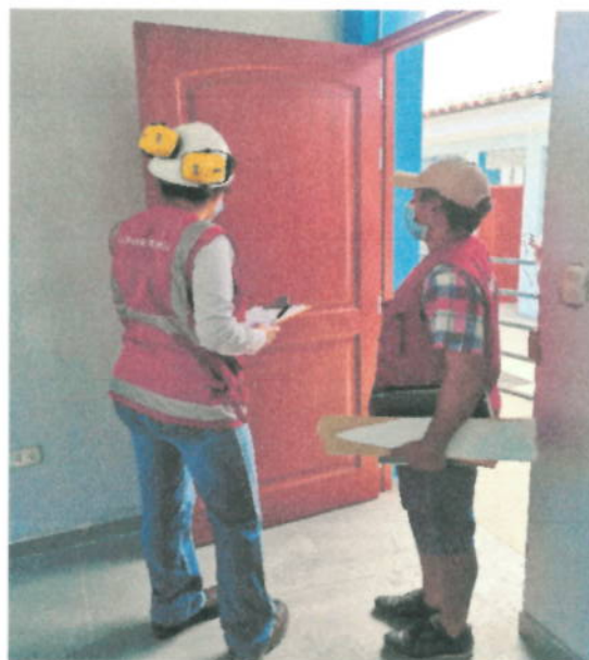
Fotografías n.°s 2 y 3.- En los dos servicios higiénicos se encontró puertas contraplacadas, mientras que en resto de puertas son macizas. Todas las puertas instaladas abren hacia el interior de los ambientes.
