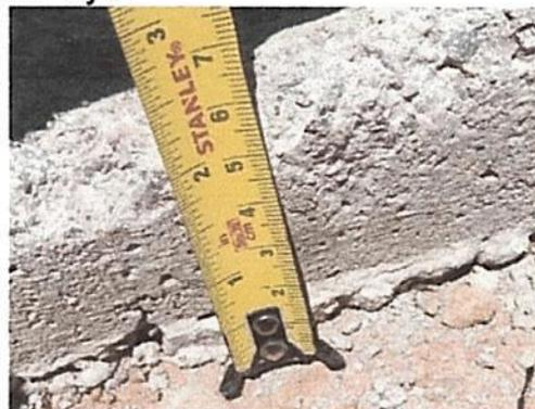
Progresiva 80+945.28 se advierte alcantarilla a nivel de solado cuyo espesor es de 6 cm.
