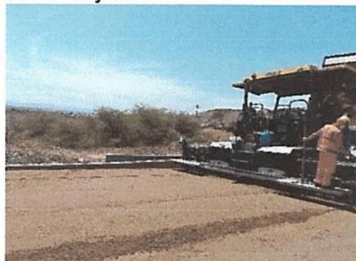
Progresiva 49 + 800 – colocación de suelo cemento con material de préstamo.
