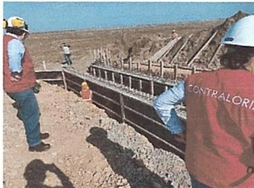
Progresiva 82+228.79 se advierten trabajos de desencofrado de muros laterales.
